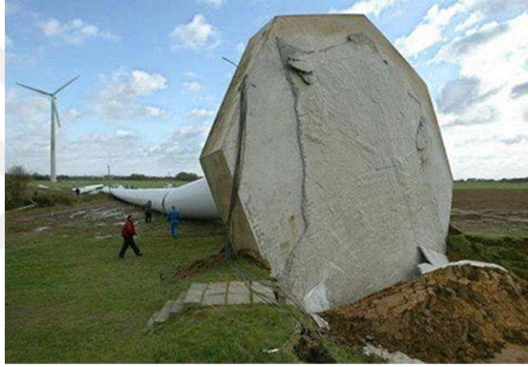
Şekil 2.12. Almanya’da aşırı rüzgar sebebiyle devrilen bir rüzgar türbini
