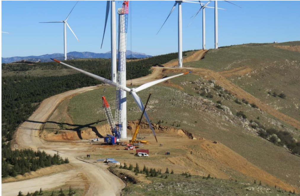
Şekil 2.3. Rotorun kule üzerinde konumlandırılması (URL-1, 2015)
