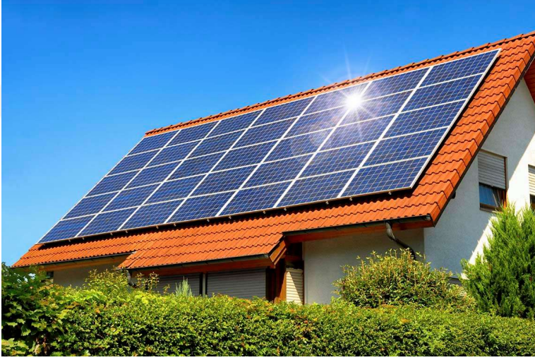
Şekil 24. Konut tipi fotovoltaik sistem örneği (URL-16, 2024)
