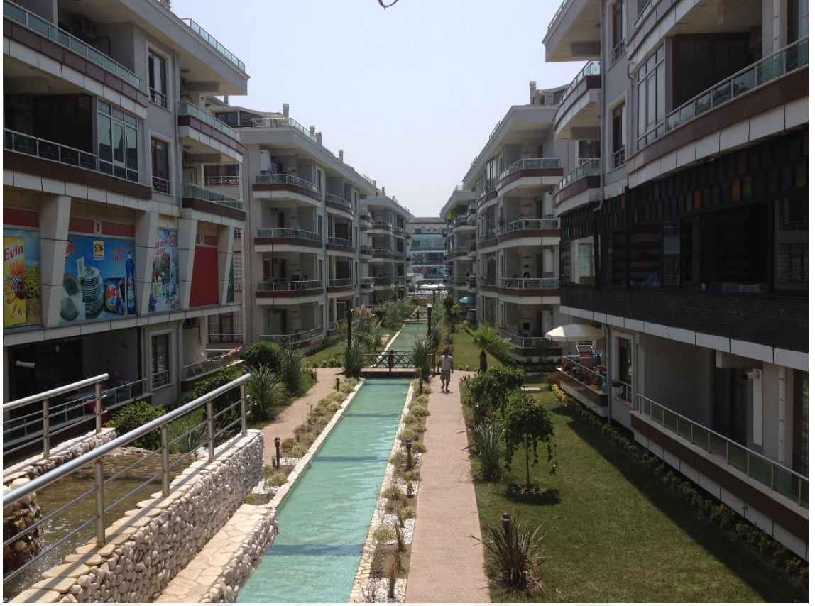
Foto 27: Aşırı Su Kullanımına Sebep Olan Konutlar.
