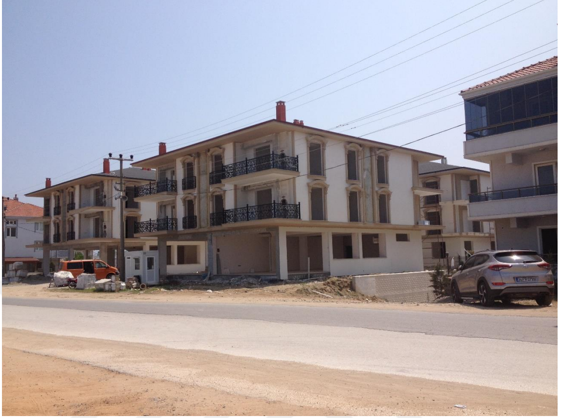
Foto 28: Yapımı Devam Eden Konutlar.
