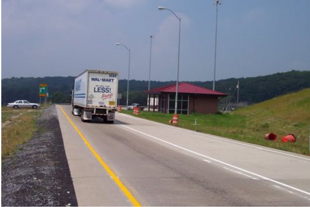
Resim 2.7. Anayol üzerindeki WIM istasyonunda yeterliliği sağlayan araçların yönlendirildiği By-Pass şeridi (1)
