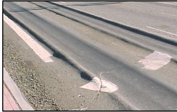
Şekil 2.8. Esnek üstyapıda tekerlek izi oluşumu (Karařahin, 2014).
