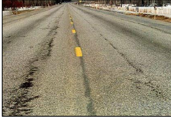
Şekil 2.10. Sökülme ve soyulmaların genel görünümü (Karaşahin, 2014)
