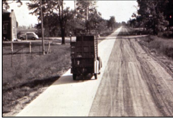
Şekil 2.2. ABD’de 1910 yılında inşa edilen beton yol (Snyder, 2008).
