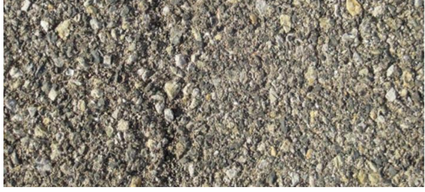
Şekil 1.16. Yol kaplamasındaki soyulma kusuru (Anonymous 2021c)
