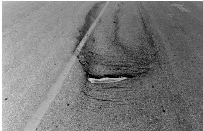
Şekil 1.7. Yolda oluşan kayma (itme) kusuru örneği (Anonymous 2015)
