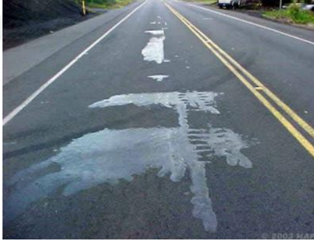
Şekil 1.17. Yol kaplamasındaki kusma kusuru (Anonymous 2021f)
