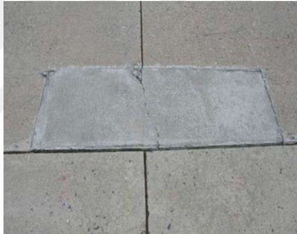
Şekil 1.3. Yama yapılmış beton yol (Anonymous 2021c)
