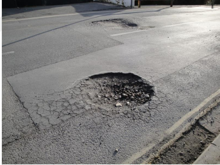
Şekil 1.19. Yol kaplamasındaki folluk tipi oyuk kusuru (Anonymous 2016a)
