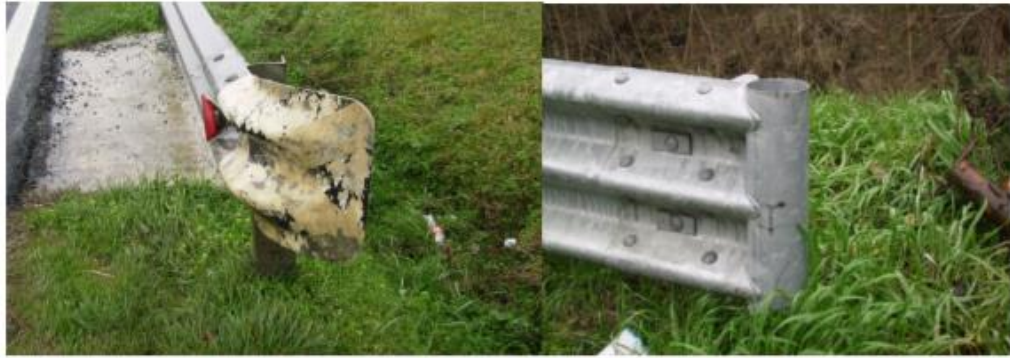
Şekil 4.6. Korunmasız bariyer bitişleri (La Torre 2012)
