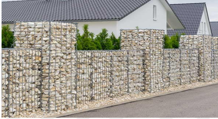
Şekil 24. Gabion duvarlar (URL-5,2021).
