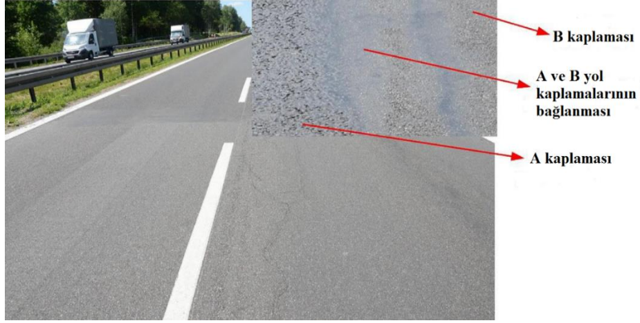
Şekil 40. A ve B kaplamalarının test bölümü ( Nowoswait vd., 2020).
