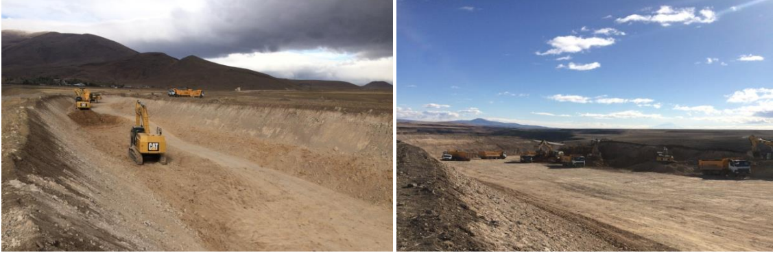
Şekil 3.8. Digor-Esenkent yolu, kazı (yarma) çalışması
