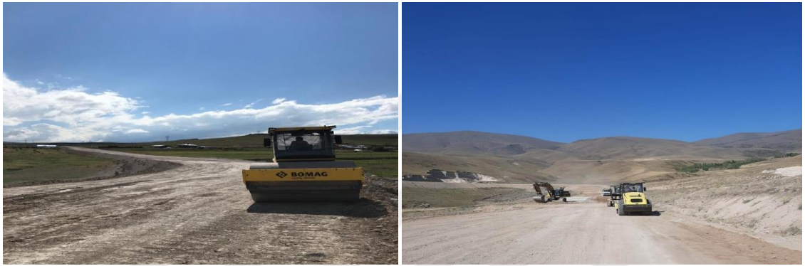
Şekil 3.9. Digor-Esenkent yolu, dolgu çalışması
