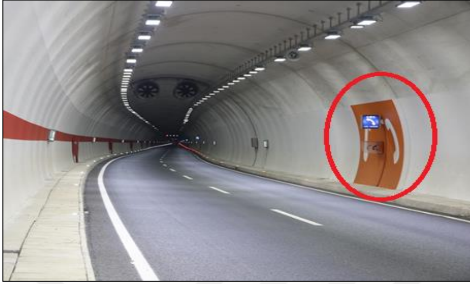
Şekil 1.22. Tünellerde kullanılan acil durum telefonları
