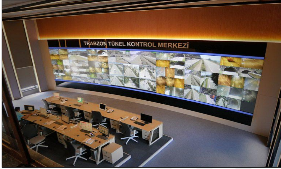
Şekil 1.24. Kapalı devre video izleme sistemleri (URL-16, 2020).
