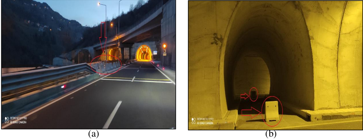
Şekil 4.1. Yeni Mačka Tünelinde New jersey ile kapalı refüj geçidi (a) ve bağlantı yolları (b)
