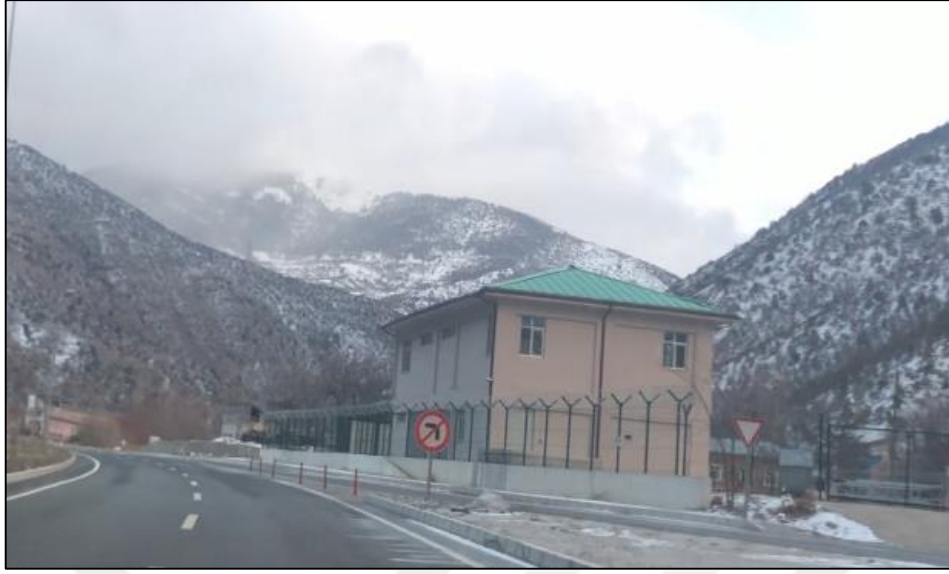
Şekil 1.11. Tünel kontrol binası
