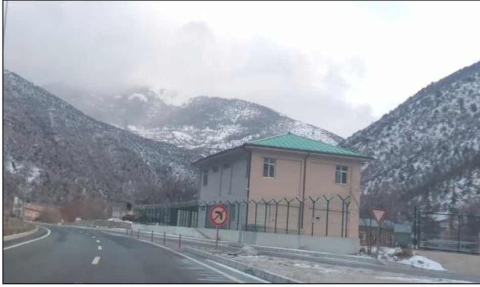
Şekil 2.9. Kürtün Kavşağı, Köprübaşı, Torul tünellerine ait olan tek alt kontrol merkezi
