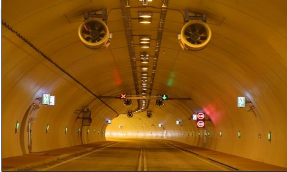
Şekil 1.8. Tünel boyuna havalandırması sistemi (URL-11, 2020).
