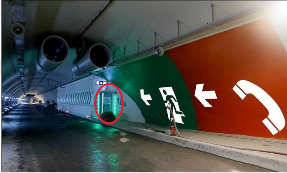
Şekil 1.3. Tünel tüpüne paralel boşaltma güzergâhı (URL-24, 2020).
