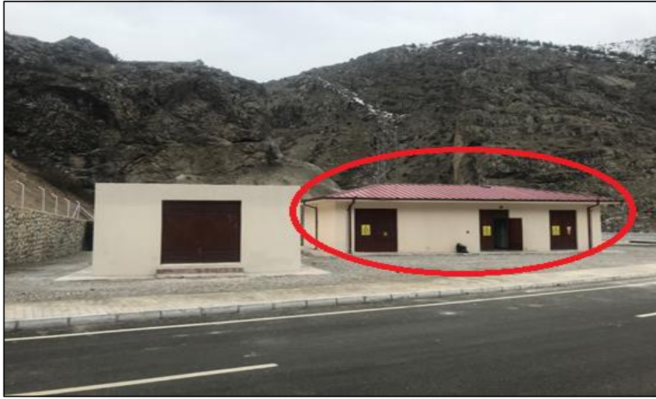
Şekil 1.14. Karayolu tüneli elektrik dağıtım binası
