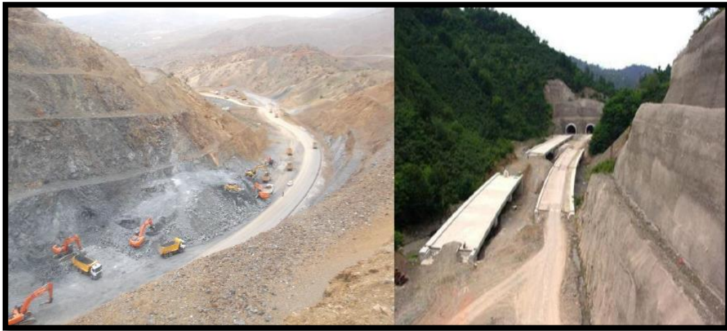
Şekil 2.12. Altyapı çalışması (Akpolat,2018)
