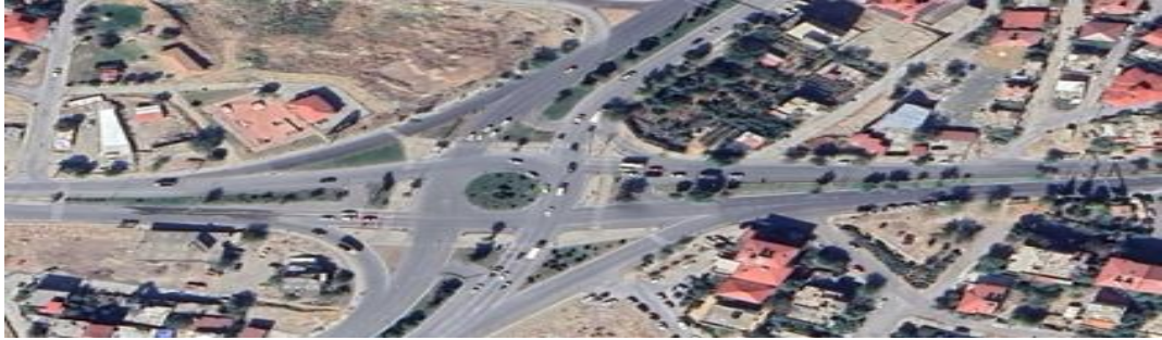
Şekil 3.9. Ağcalı kavşağının mevcut görünüşü
