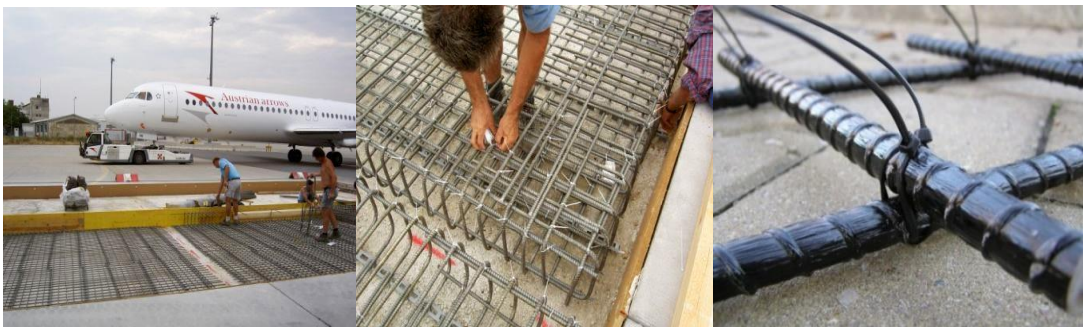
Şekil 2.6. Lif takviyeli kompozit donatıların havalimanında kullanımına örnek [22].
