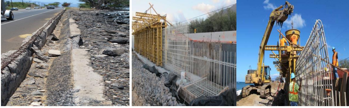
Şekil 2.2. Korozyona uğramış bir kıyı şeridi istinat duvarının lif takviyeli kompozit donatılarla tekrardan inşaatı [19].
