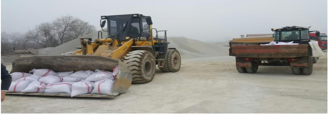
Şekil 5.1. Agregaların beton santrali stok sahasından alınması.
