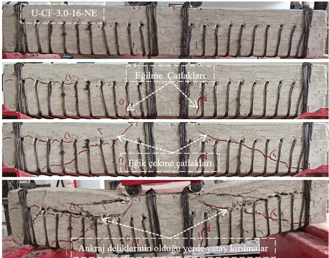
Şekil 4.18. U-CF-3.0-16-NE kiriş numunesine ait göçme sonrası hasar detayları
