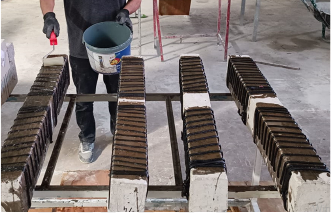
Şekil 3.12. Güçlendirmede kullanılan FRP iplerin epoksi ile uygulanması
