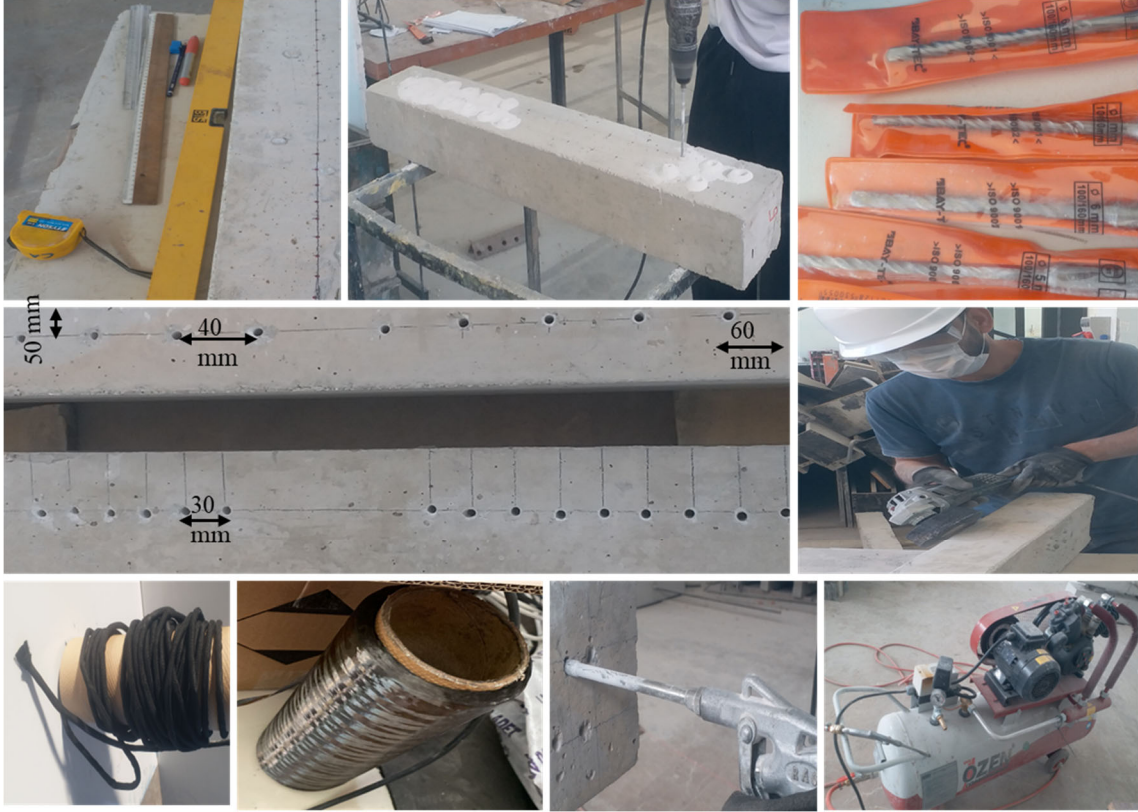
Şekil 3.10. Güçlendirme adımları ve bu adımlarda kullanılan ekipmanlar
