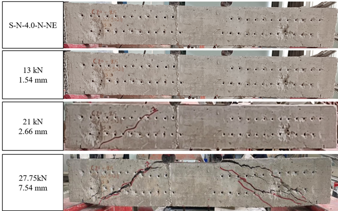
Şekil 4.1. S-N-4.0-N-NE kodlu delikli referans kiriş numunesine ait çatlak oluşum aşamaları
