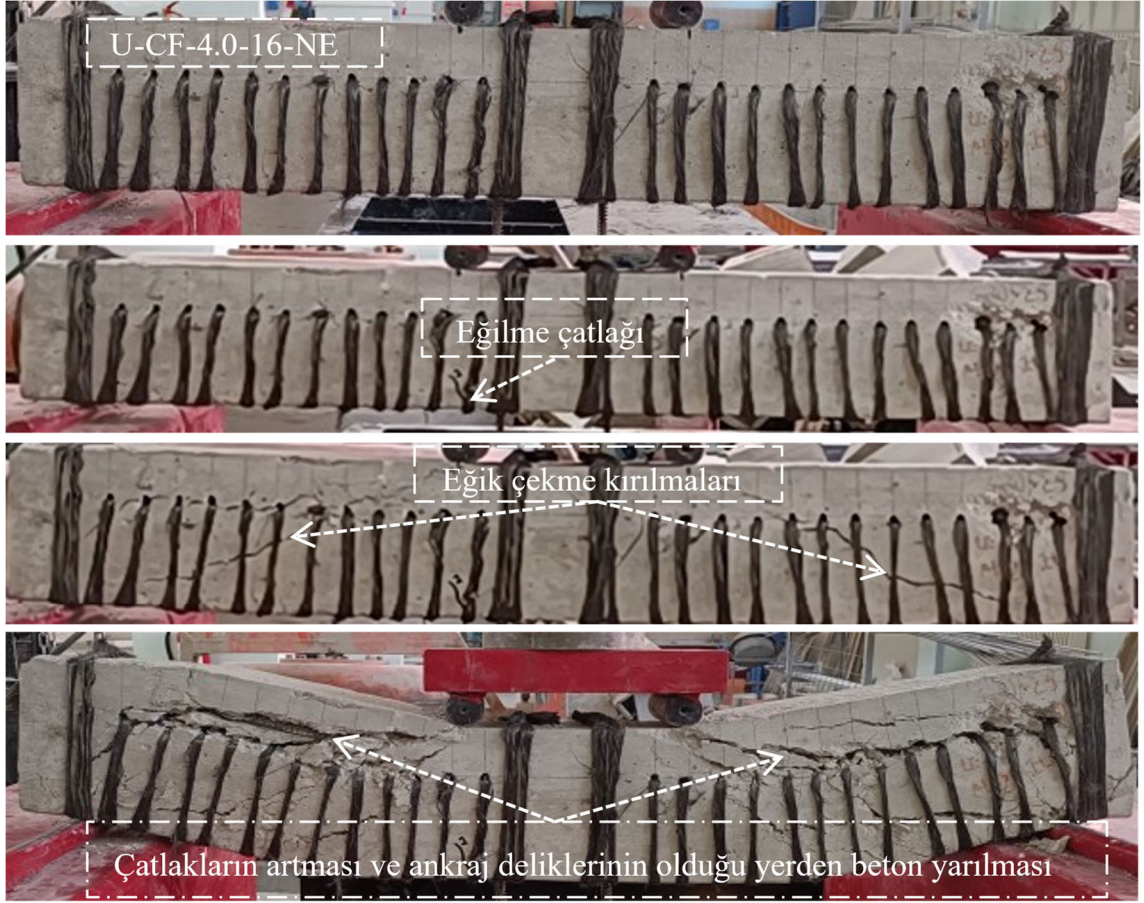
Şekil 4.9. U-CF-4.0-16-NE numunesine ait göçme sonrası hasar detayları
