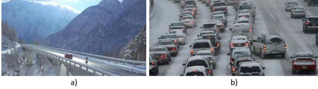
Resim 2.1 Buzlanma; a) Köprülerde, b) Karayollarında (İnt. Kyn. 2).
