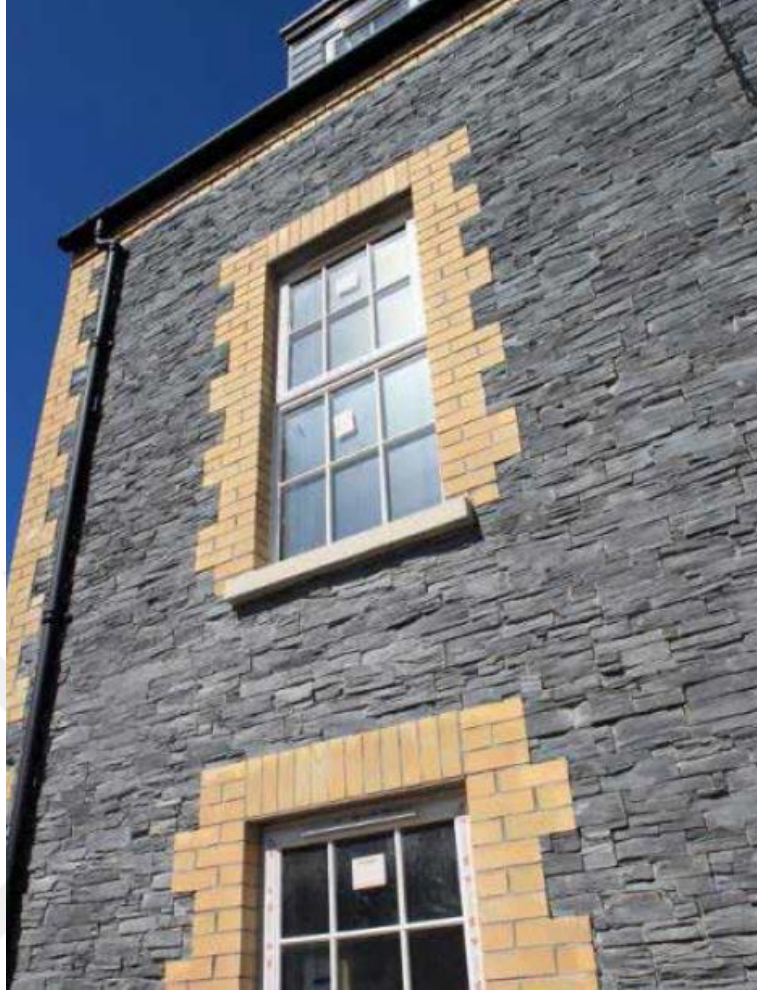
Resim 2.2 Harçlı yöntem (İnt. Kyn. 3)
