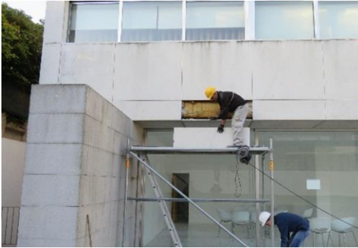
Resim 1.1 Dış cephe kaplamalarında meydana gelen düşmeler (Sousa ve Sousa 2019)
