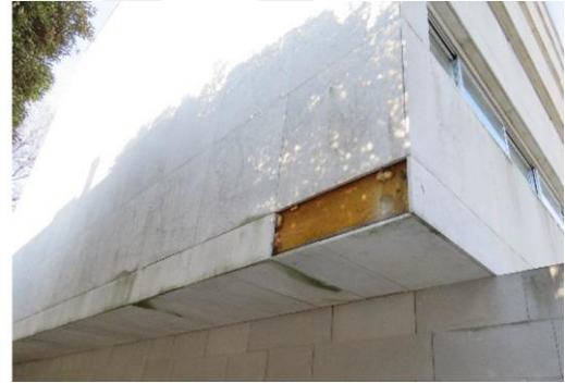
Resim 1.1 Dış cephe kaplamalarında meydana gelen düşmeler (Sousa ve Sousa 2019)
