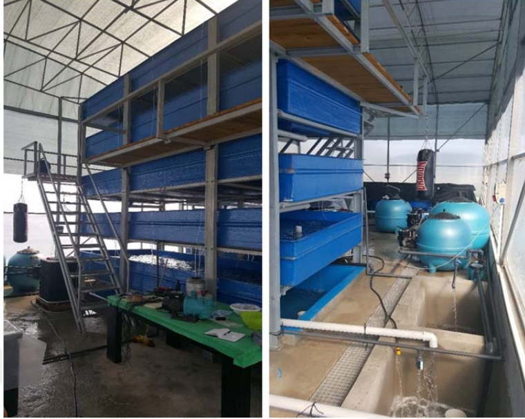
Şekil 3.7. II. Denemede kurulan ve RAS olarak kullanılan katlı tank sistemi.
