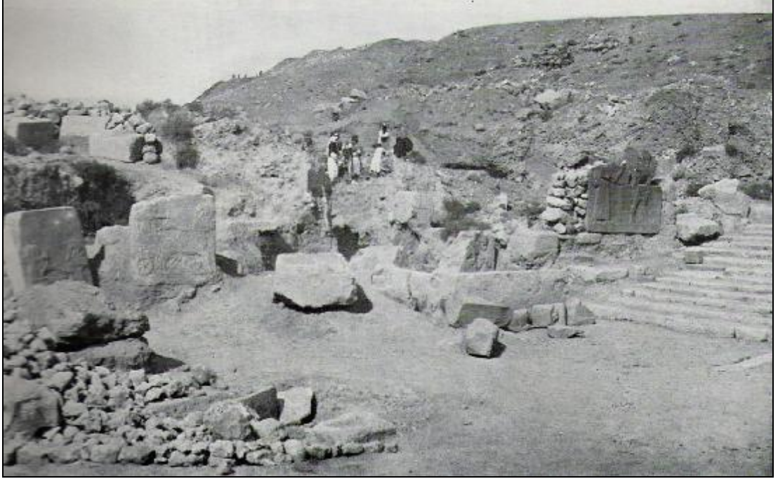
Şekil 4.78. Büyük Merdiven ve Uzun Duvarın Alt Başlangıř Noktası (Wooley ve ark., 1978)
