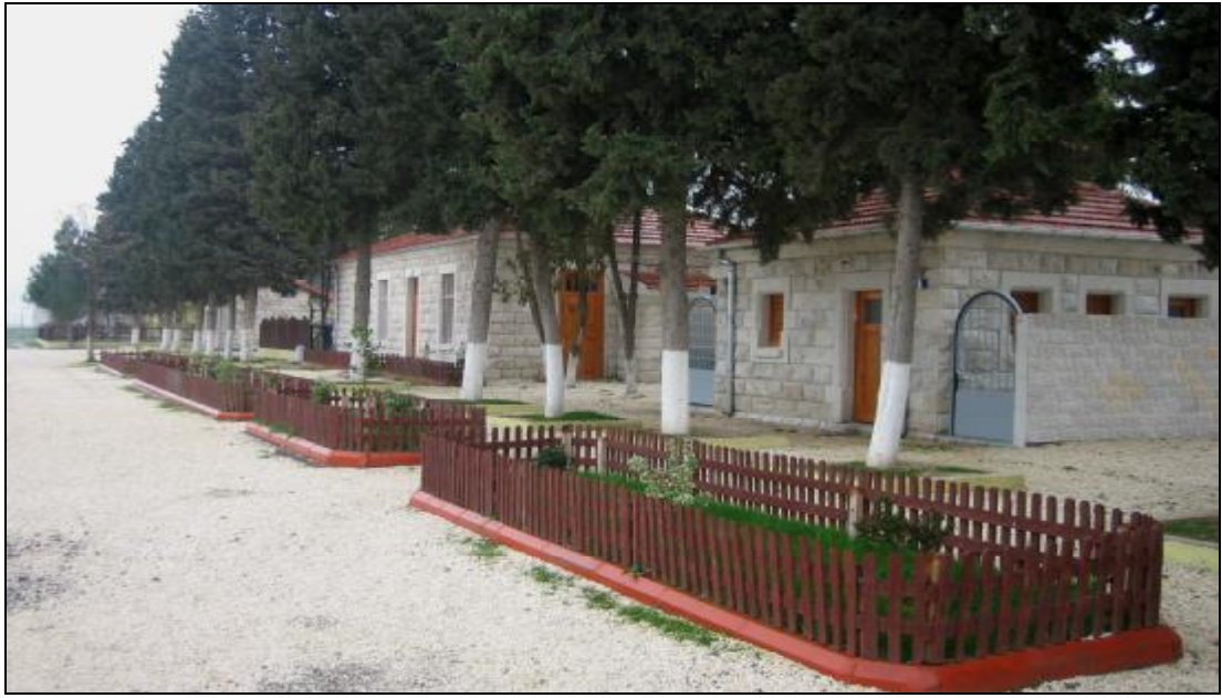
Şekil 4.51. Devlet Demiryolları 6. Bölge Müdürlüğü Lojmanları
