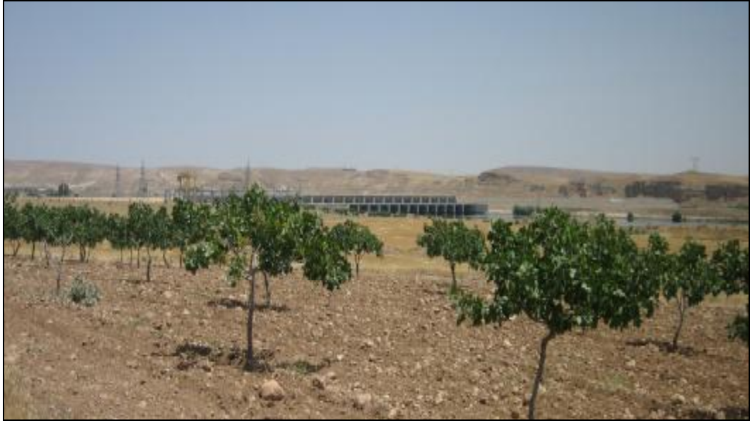
Şekil 4.26. Karkamış Barajı Çevresi'nden Görünüm
