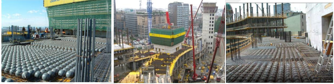
Şekil 3.27 Palazzo Lombardia yapısı döşemeleri için Cobiax marka yüksek yoğunluklu polietilen (PEHD) küre uygulaması görselleri (Brasca, 2010; Mola ve diğer., 2014; Peikko, 2018)
