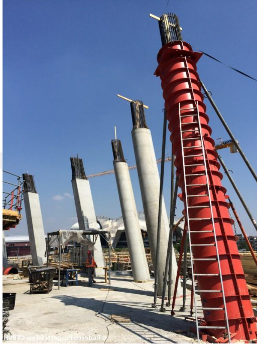
Şekil 3.49 Kolon imalatları (Skyscrapercenter, 2019)
