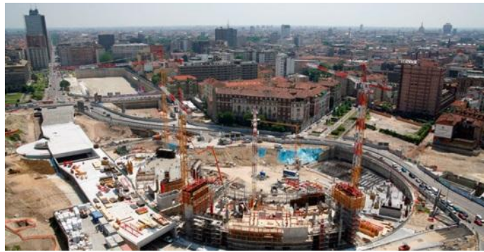
Şekil 3.11 Porta Nuova Garibaldi yapısı inşaat aşaması (Peri, 2016; Tekne, 2016)
