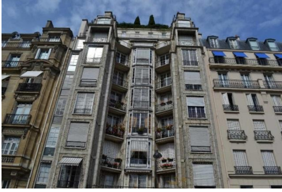
a) Rue Franklin Apartmanı cephe fotoğrafı
