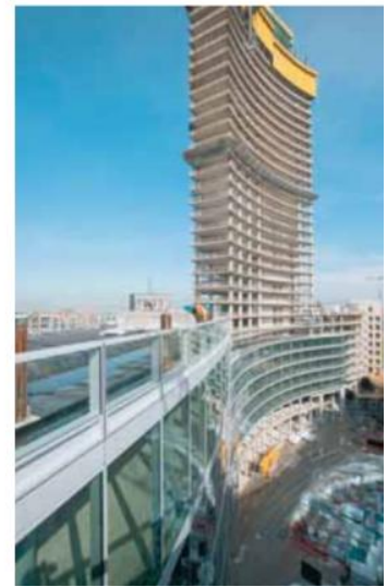
b) İnşaat safhasına ait görüntü
