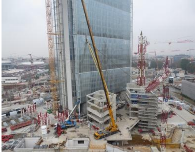
a) Allianz Tower yapım safhasına ait görüntü
