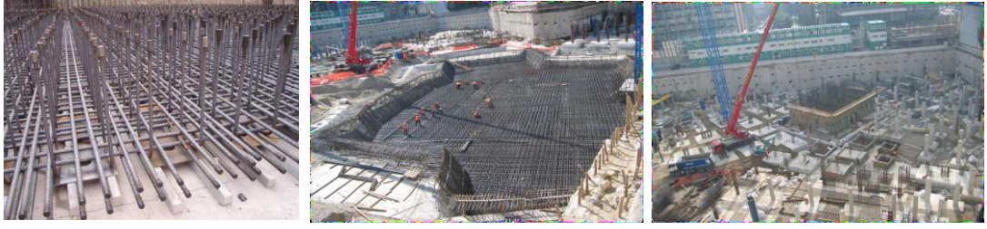
a) Manşonlu temel donatıları b) Radye temel donatı imalatı c) Kaideler
