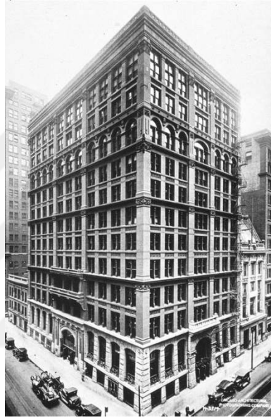
Şekil 8. Home Insurance Company Binası, Chicago , Url 20
