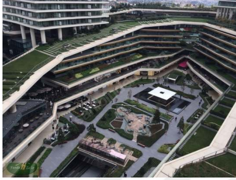
Fotoğraf 39. Zorlu Center Ofis Katları Görünüşü, Url 48
