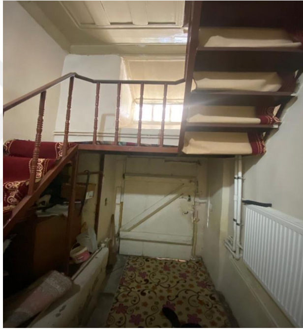
Fotoğraf 4.14. Ahşap Merdiven
