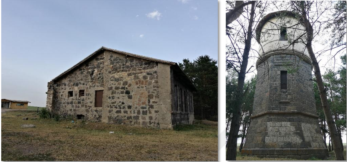
Görsel 3.68 ve Görsel 3.69 Benliahmet Tren İstasyonu İşçi Barakası ve Su Deposu
