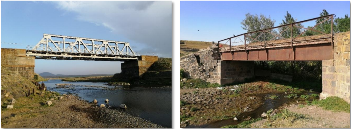
Görsel 3.63 ve Görsel 3.64 Kars Çayı Üzerinde Benliahmet Demiryolu Güzergâhında Kurulmuş Çelik Köprü ve Kars Çayı'na Katılan Küçük Bir Dere Üzerinde Kurulmuş Çelik Köprü
