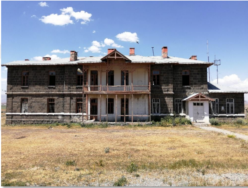
Görsel 3.65 Selim Tren İstasyonu Gar Binası
