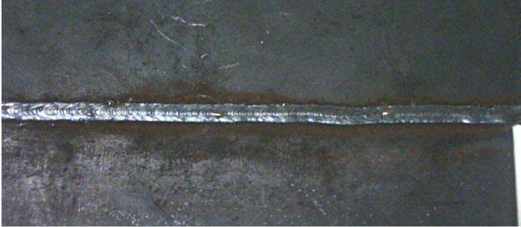
Şekil 3.6 Kaynak uygulaması (w2)
