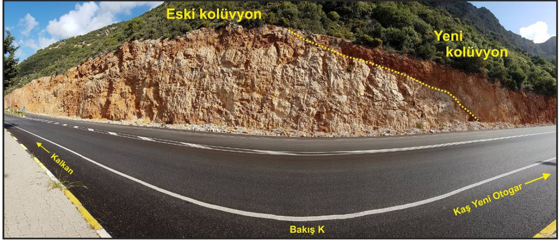
Şekil 3.9. Kaş kuzeyindeki yol yarmasının doğu kesiminde, eski-yeni kolüvyon ayrımı (Ölçeksizdir.)
