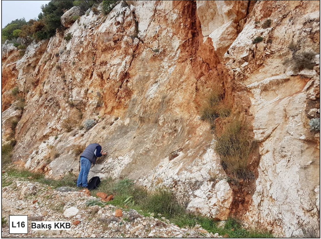
Şekil 4.6. L16 lokasyonuna ait fay düzlemi ve açılma çatlağı
