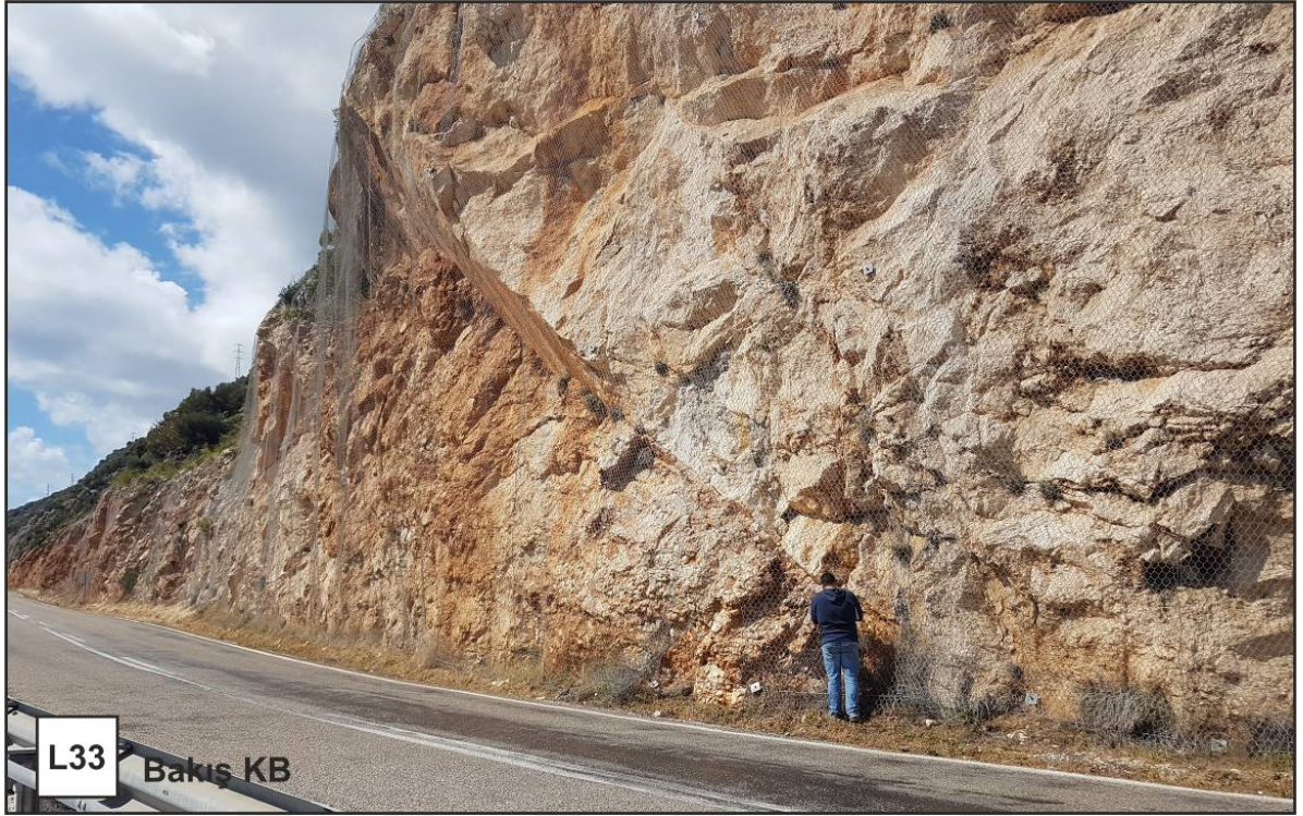
Şekil 4.7. L33 lokasyonundaki ters fay düzlemi (Bakış KB)
