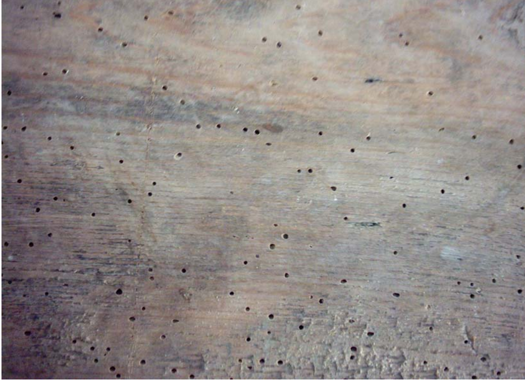
Resim 4.1. Kastamonu evlerinde kullanılan ahşaplarda Anobium punctatum (Deg) erginlerinin çıkış delikleri
