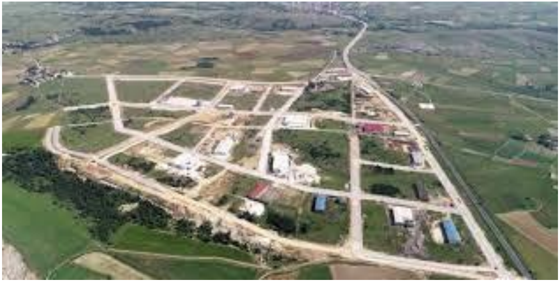
Şekil 2.11 Seydiler OSB genel görünüm
