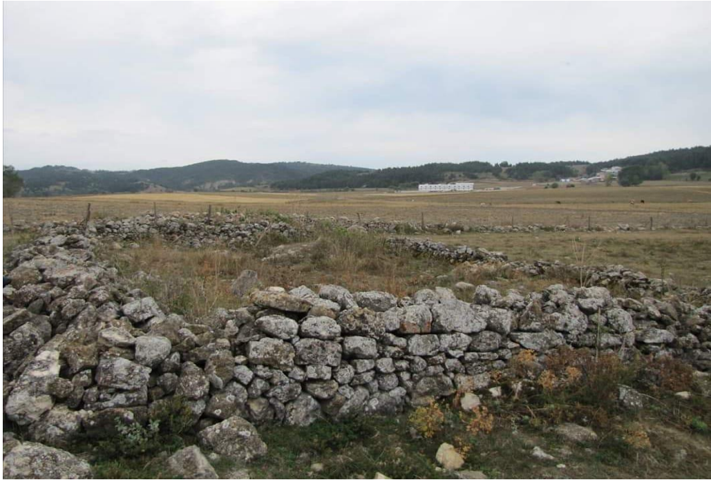
Resim 18. Sâhib-i Divan Türbesi-Yazlıhisar Köyü/ Devrekâni İlçesi (18.09.2019 tarihli saha çalışması).
