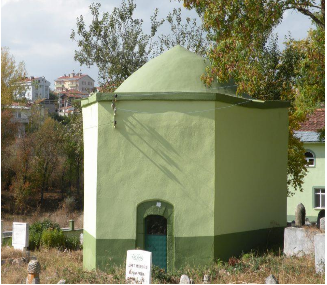
Resim 5. Kurt Şeyh Türbesi-Devrekâni İlçe Merkezi (17.07.2019 tarihli saha çalışması).
