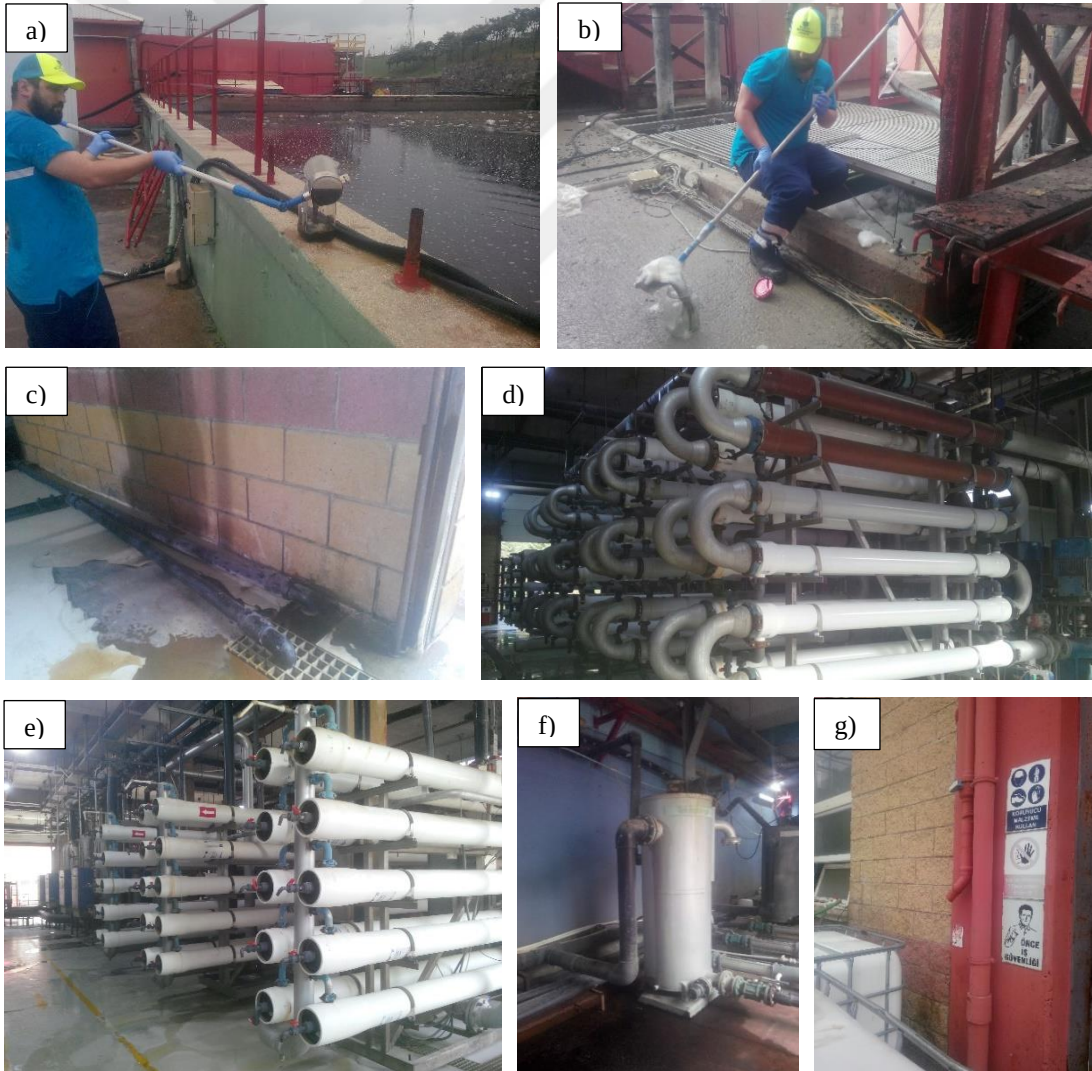
Şekil 3.4. İSTAÇ SAT numune alma noktalarına ait fotoğraflar; a) Lagün/ön çöktürme, b) Lagün çıkışı, c) Biyoreaktör çıkışı, d) UF, e) NF, f) Dekantör girişi, g) Konsantre/depolama alanı
