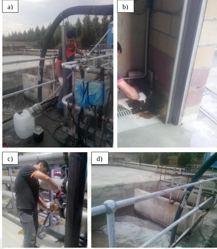
Şekil 3.8. İZAYDAŞ SAT numune alma noktalarına ait fotoğraflar; a) Çöp suyu giriş, b) Aerobik çıkışı/bioreaktör çıkışı, c) UF çıkışı, d) UF geri devir/anoksik havuz
