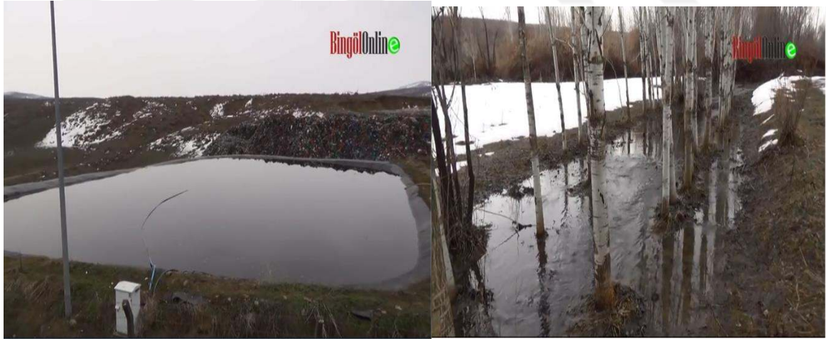
Şekil 1.2. Katı atık sızıntı suyu havuzlarında suyun taşması
