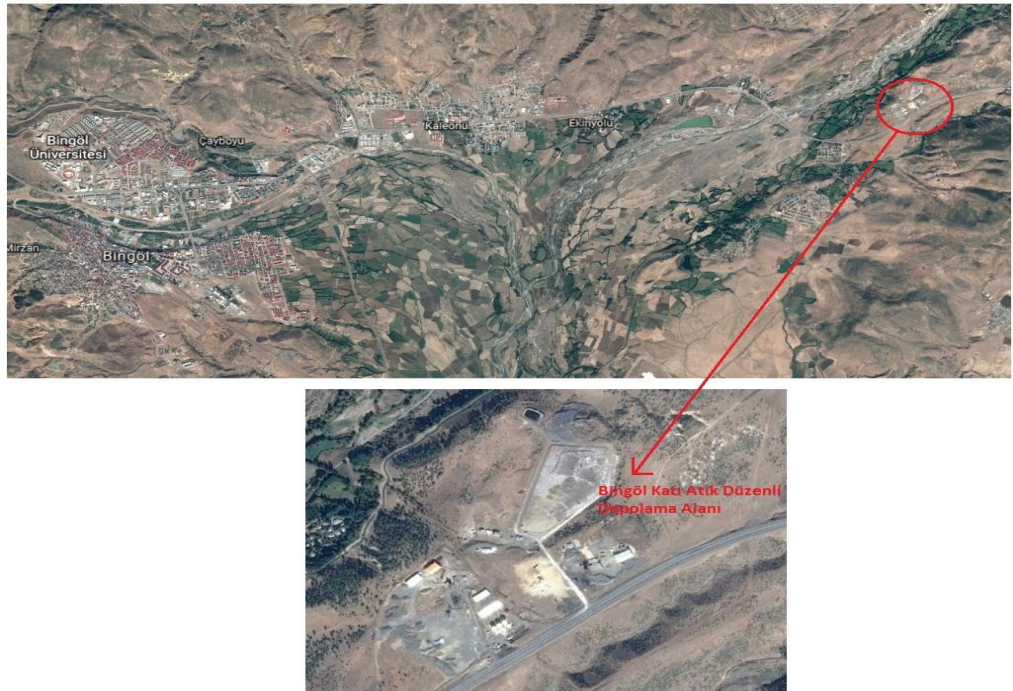
Şekil 4.1. Bingöl katı atık düzenli depolama alanı
