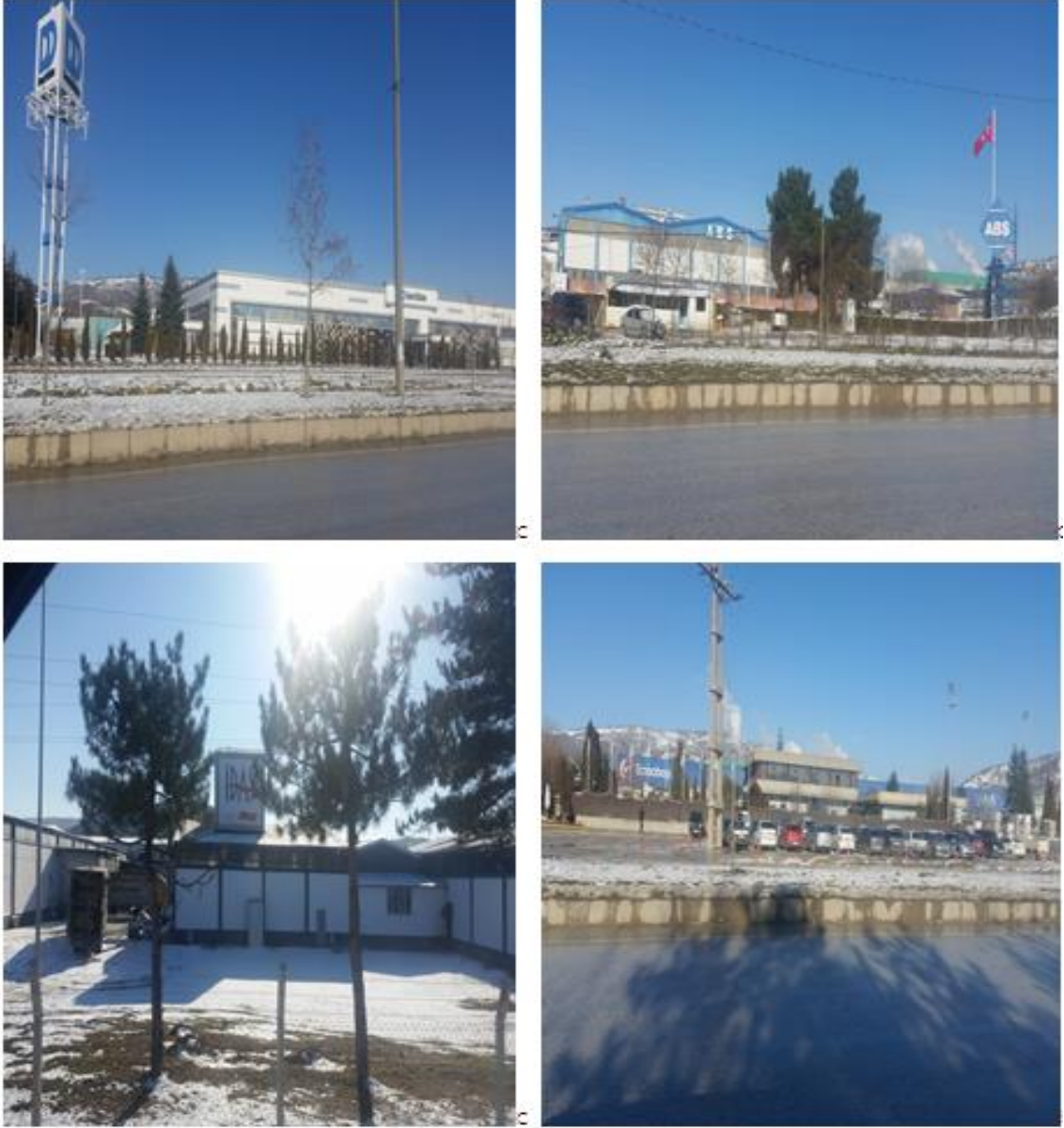
Şekil 4.4. Bozüyük sanayii tesisleri
