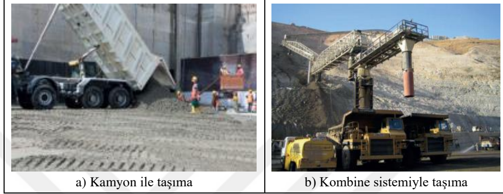
Şekil 3.6. SSB'yi baraj alanına kamyonla ve kombine sistemiyle (konveyör-kamyon) taşınması (Sika, 2019)
