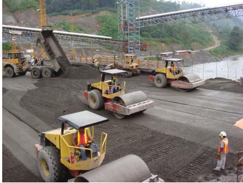
Şekil 3.8. SSB sıkıştırma (Shaw, 2010)
