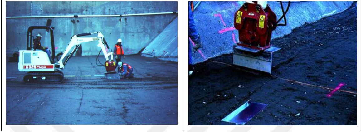
Şekil 3.10. Pueblo Barajı'nda çatlak indükleyicili bir bağlantı oluşturmak için galvanizli çelik sac levhasının montajı (USBR, 2017)
