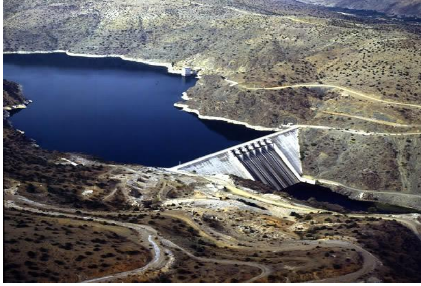
Şekil 3.2. Sakarya’da bulunan beton ağırlık türünde Sarıyar Barajı (Selçuk, 2019; Güneş, 2020)
