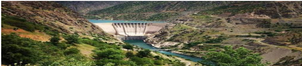
Şekil 3.5. Diyarbakır, Çüngüş'te bulunan Karakaya Kemer Barajı (Selçuk, 2019; Güneş, 2020)
