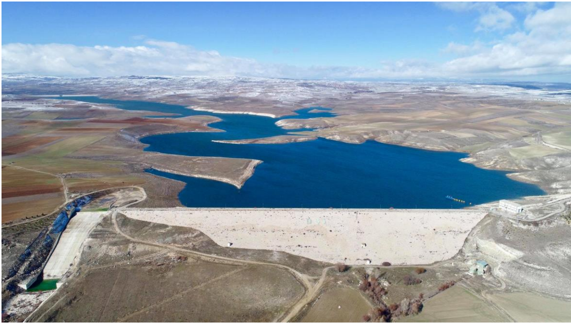
Resim 3.1 Afyonkarahisar Akdeğirmen Barajı
