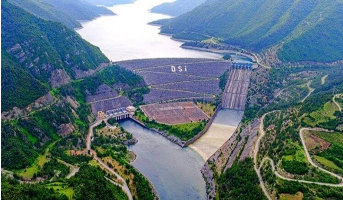
Resim 2.5 Hasan Uğurlu Barajı Kıl çekirdekli kaya dolgu tipindeki bir baraj (İnt.Kyn.4)
