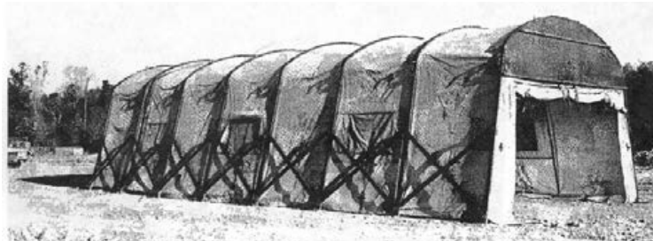
Şekil 24. Akordiyon barınak. (Bu barınağın boyutları 4,88 m x 10,67 m x 3,05 m’dir ve paket boyutu sadece 2.80 m 3 ’tür. Barınağın inşası için 8 insan 12 dakika yeterlidir (Thrall & Quaglia, 2014: 687)).
