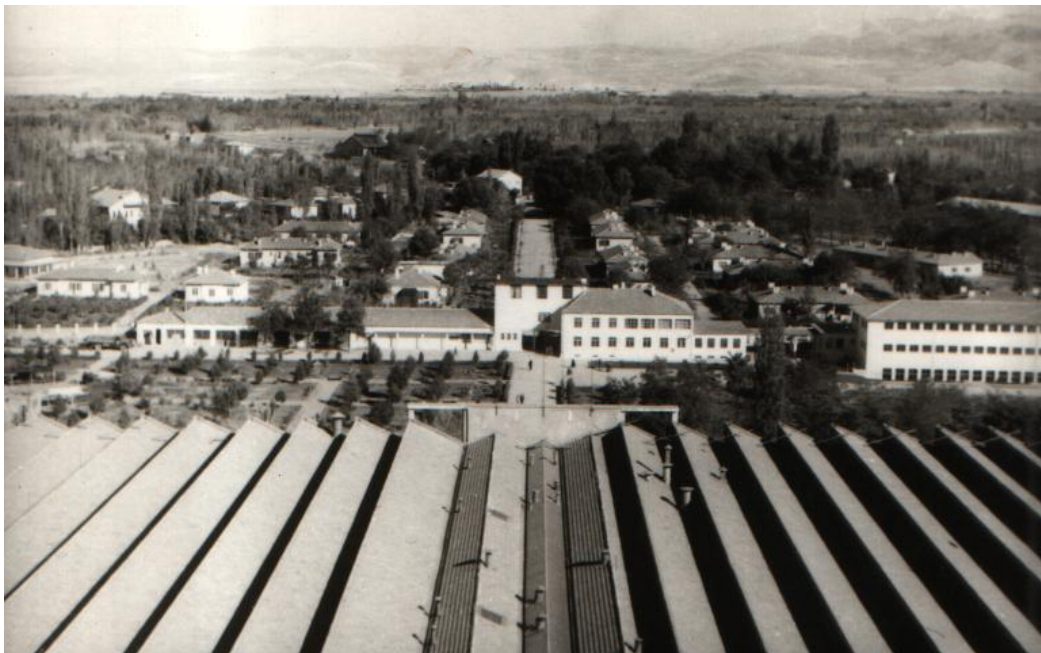
Şekil 4. 49. Memur evlerinin fabrikadan görünüşü (EBA, 2022)
