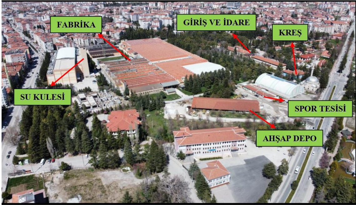
Şekil 4. 37. Fabrika yapısı 2022 drone fotoğrafı (Kocadağ, 2022)
