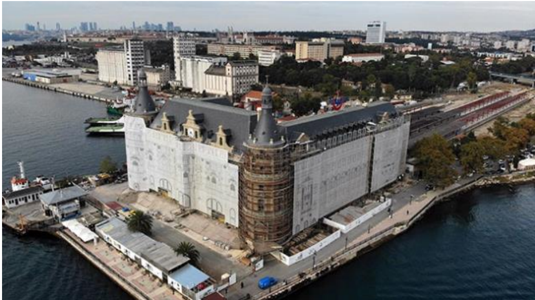
Şekil 2. 18. Haydarpaşa garı restorasyon çalışmaları (Url- 11).
