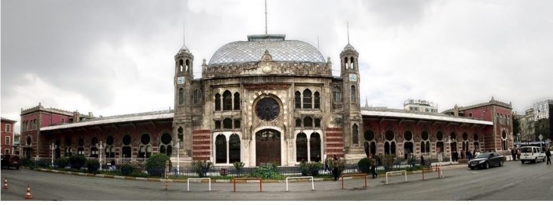
Şekil 2. 31. Garın kuzey cephesine ait bir fotoğraf (Url-24).
