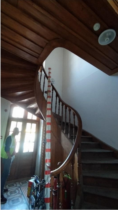
Şekil 4. 18. Gar binası iç merdiven
