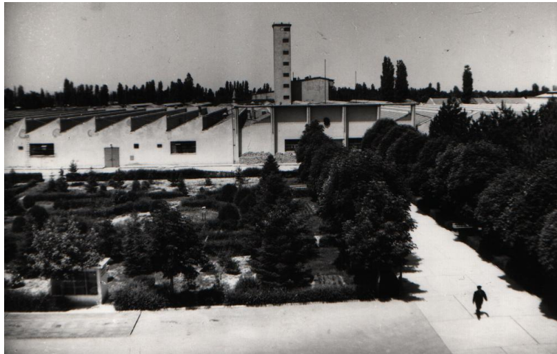
Şekil 4. 39. Fabrika ve su kulesine ait eski bir fotoğraf (EBA, 2022)
