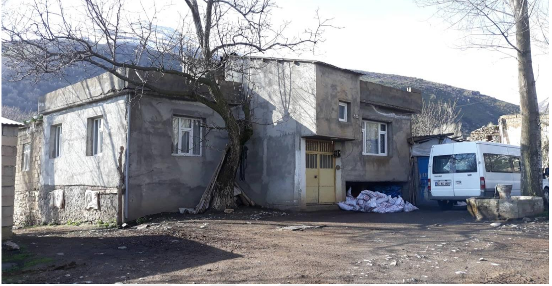
Fotoğraf 2. Tersine Göçten Sonra Eski Köy Evi Üzerine İnşa Edilen Yeni Köy Evi
