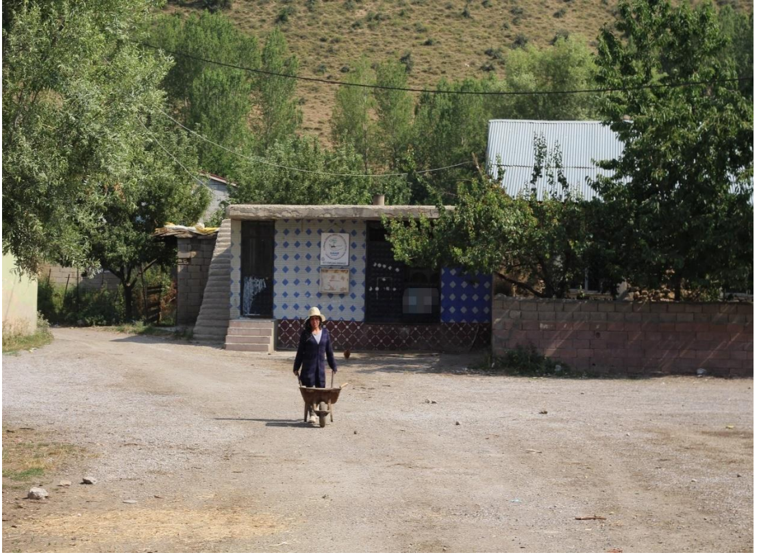
Fotoğraf 12. Kolbaşı Köyün İnşa Edilen Süt Deposu
