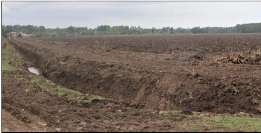
Şekil 20. Fazla suyun bertarafı için açılan drenaj kanalları
