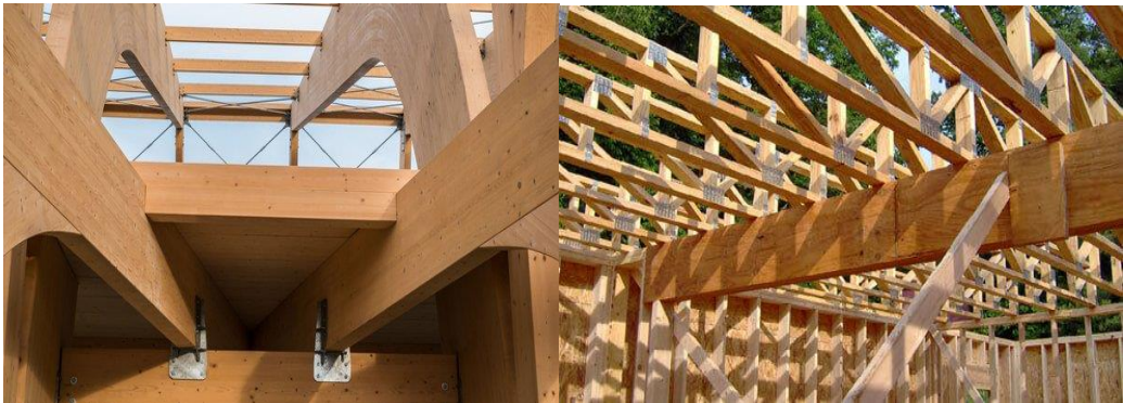
Şekil 1.2: KTK’nın yapı elamanlarında kullanımı.
