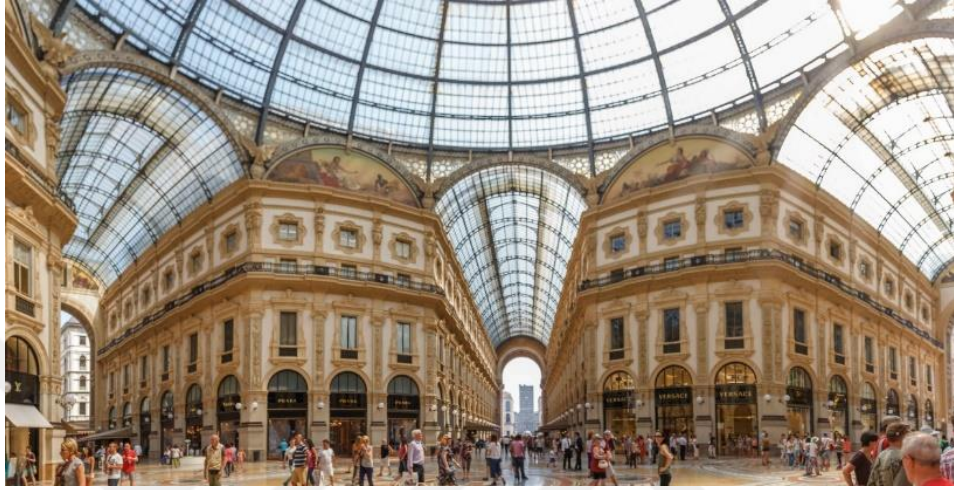
Şekil 1. Milano/Galleria Vittorio Emanuele II, Arkadların Demir Dökümle Birleşmesine Örnek
