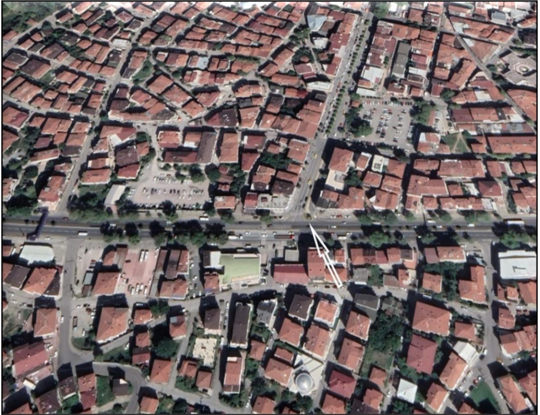
Şekil 1.4. Mevcut farklı seviyeli kavşak.
