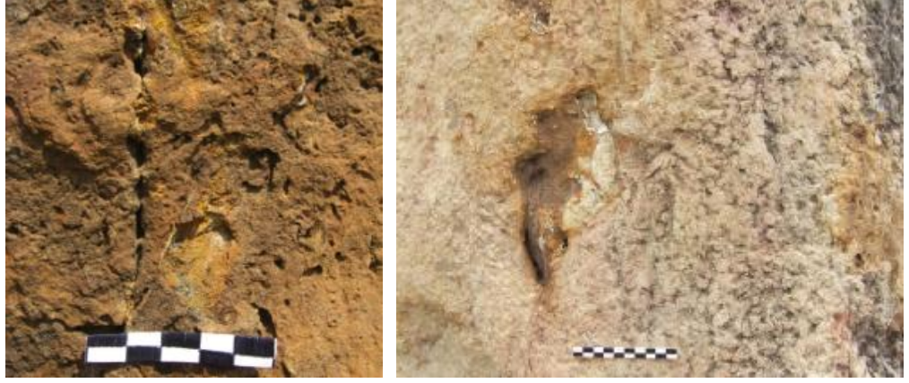
Şekil 4.4. Çukurlaşma (solda) ve mağaracık şeklindeki bozunma
