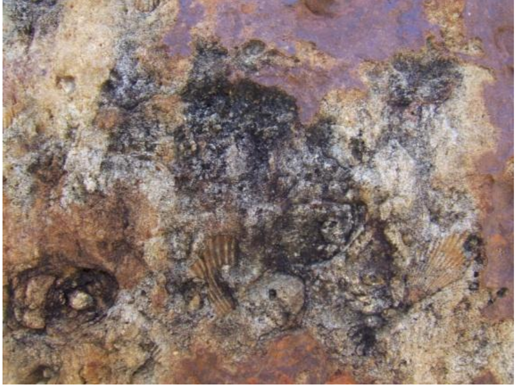
Şekil 4.5. Fosil içerikli monolitlerdeki rölyef şeklindeki bozunma
