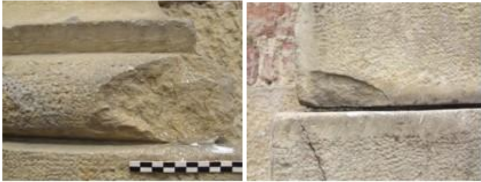
Şekil 4.24. Kırılma yoluyla parça kaybı
