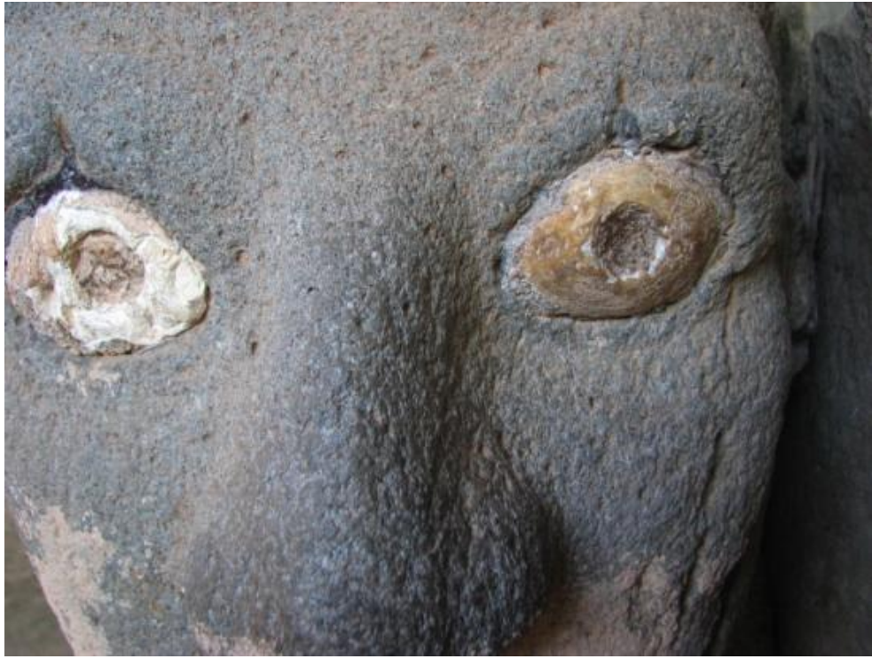
Şekil 4.36. Güney kapı girişindeki kapı sfenskinde görülen, elle dokunmadan kaynaklanan yağlı kir tabakası
