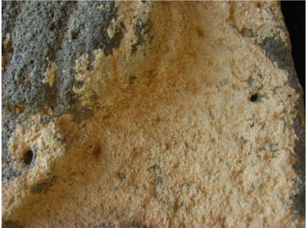
řekil 4.32. Kabartmalarda gzlenen, kalınlıęı 1 mm ile 8 mm arasında deęiřen kalkit birikimi
