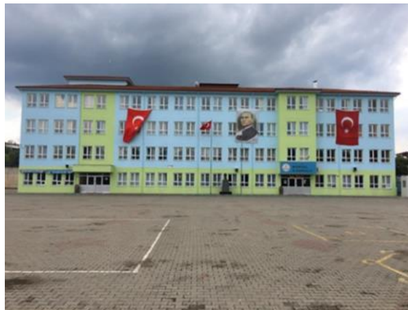
Görsel 2.1. Okul binasının bahçeden görünümü
