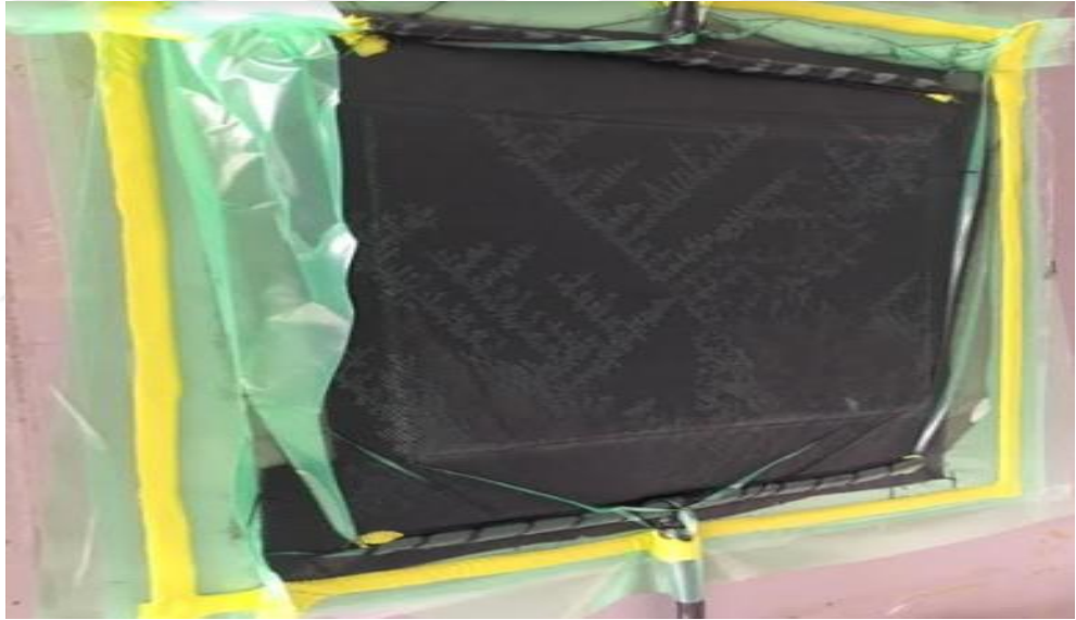
Şekil 3.20. Epoksi reçine-sertleştirici karışımın kalıp içine emdirilmesi
