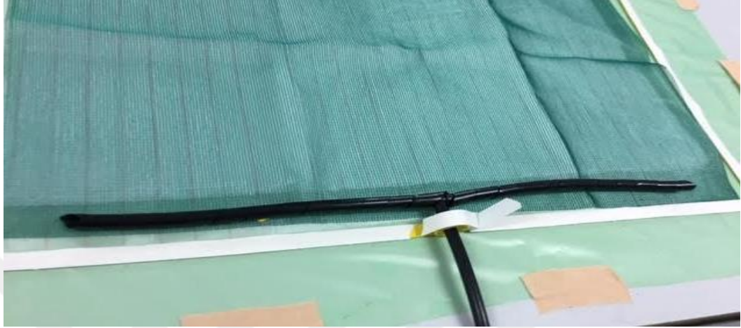
Şekil 3.17. Hortumların etrafına sızdırmazlık bandı çekilmesi
