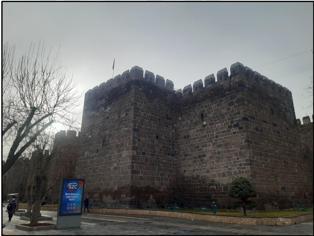
Şekil 4.13. Kayseri kale surları
