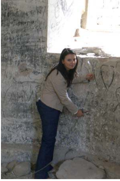
Şekil 5.17. Hortum teraziyle kırmızı kot oluşturulması
