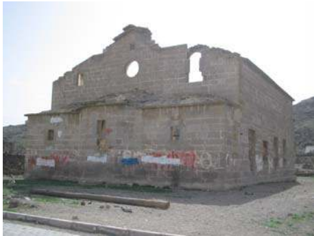
Şekil 6.96. Suvermez Kilisesi kuzeydoğudan görünüş
