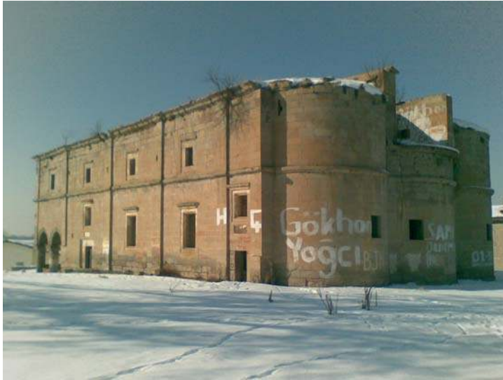
Şekil 6.3. Yanartaş Rum Kilisesi güneydoğudan görünüş
