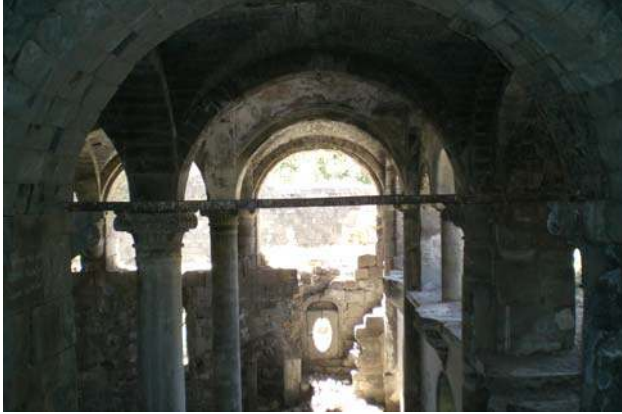
Şekil 5.91. D7 duvarı iç görünüş
