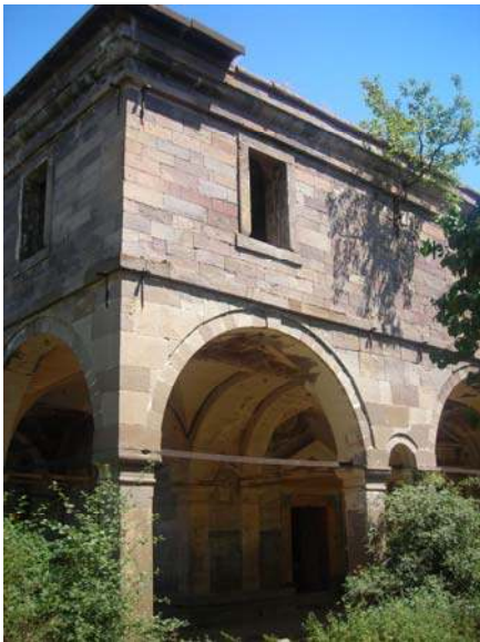
Şekil 5.36. Batı cephesi köşe
