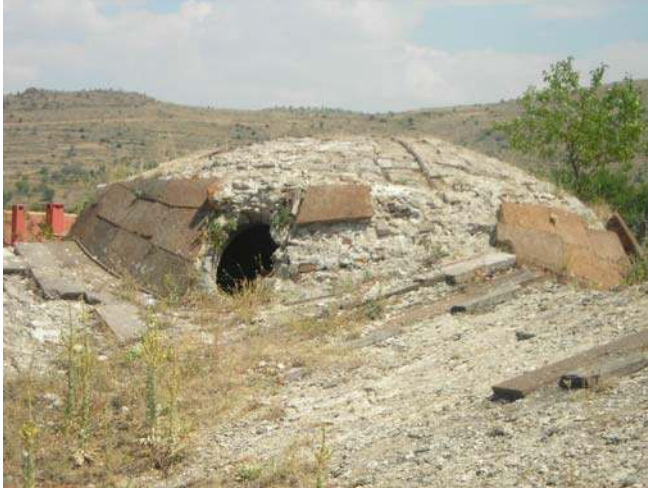
Şekil 5.139. Çatıdan kubbenin görünümü
