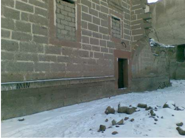
Şekil 6.20. İncesu Rum Kilisesinin kuzey duvarı
