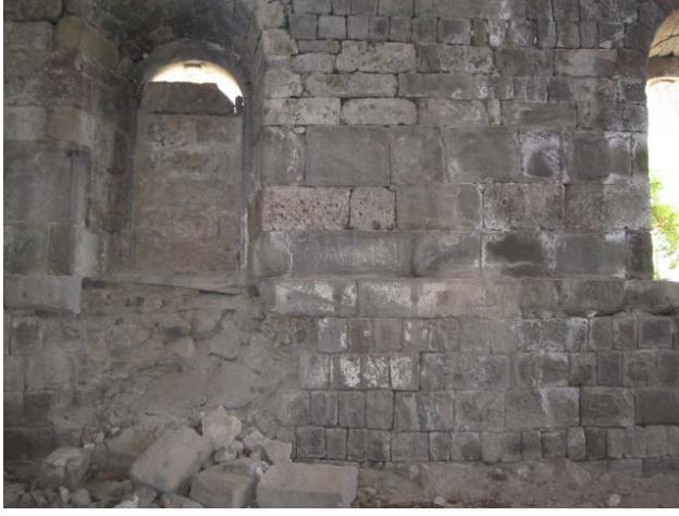
Şekil 5.95. D7 duvarı kapatılmış pencere
