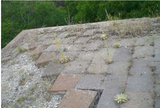
Şekil 7.42. Endürlük Kilisesi çatı kaplaması
