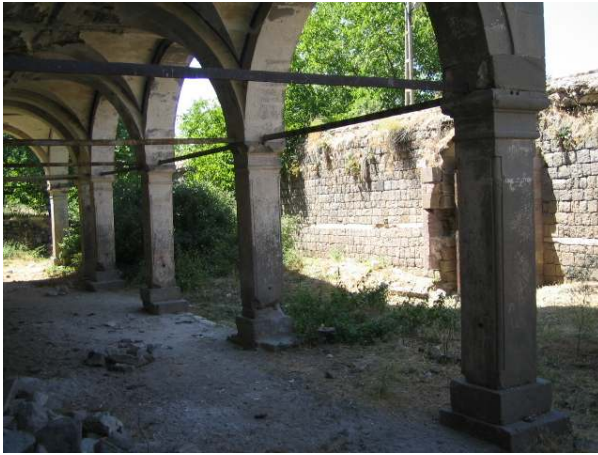
Şekil 5.30. Kuzey cephesinden sütunların görünümü
