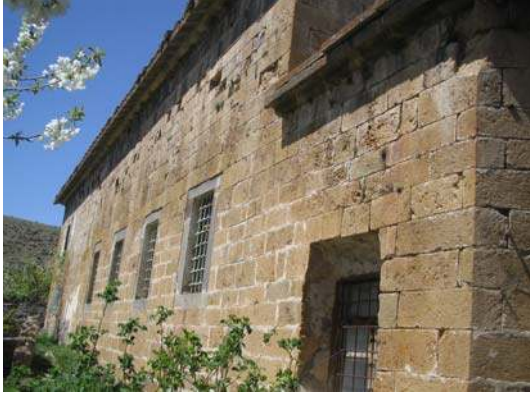
Şekil 6.58. Yeşilburç Kilisesi güney duvarı görünüş
