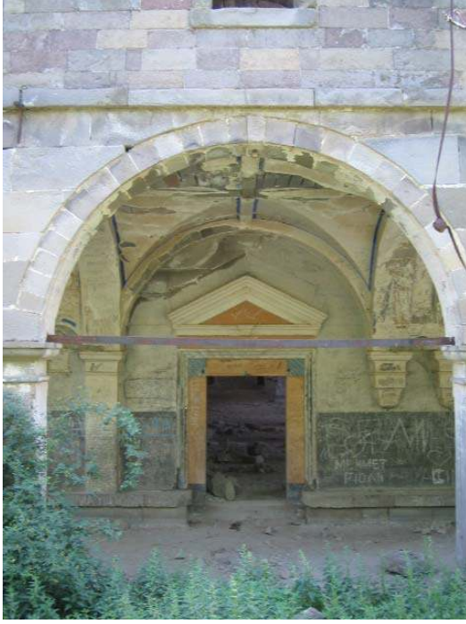
Şekil 5.40. Sol nef hizasındaki K1.2 giriş kapısı
