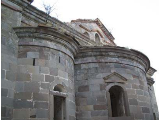
Şekil 5.63. Doğu cephesi apsislerin dışarıdan görünümü
