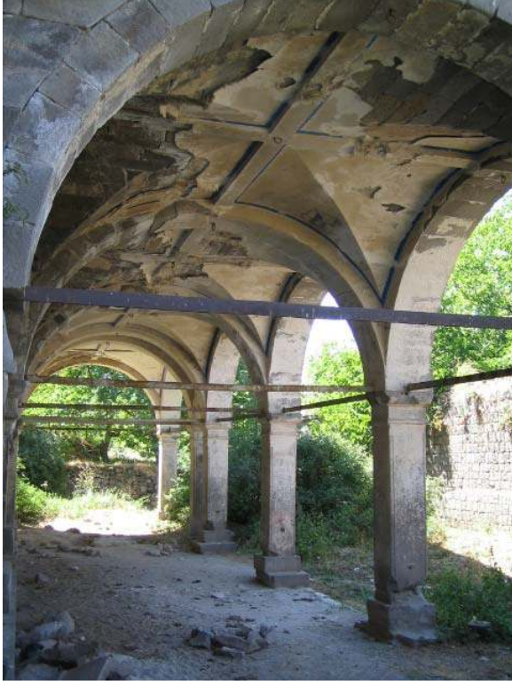
Şekil 5.32. Galeri altı görünüm
