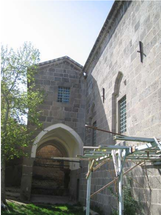
Şekil 6.54. Aşağı Kayabaşı Kilisesi güney cephesi görünüş
