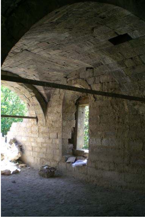
Şekil 5.123. Galeri D3 duvarı
