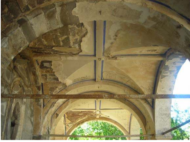
Şekil 7.25. Narteks çapraz tonozlarının görünüşü
