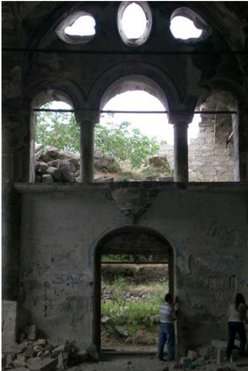
Şekil 5.72. Kilise D1 duvarının iç görünüm
