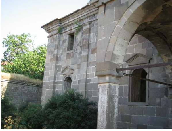
Şekil 5.20. Avludan kuzey cephesinin görünümü
