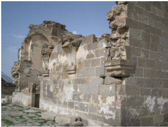
Şekil 6.99. Suvermez Kilisesi yıkılmış narteks görünüş
