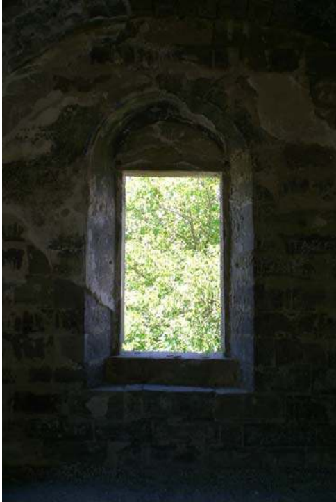
Şekil 5.122. Galeri penceresi iç görünüm
