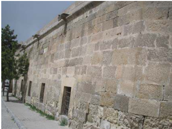
Şekil 6.72. Constantina ve Helena Kilisesi güney duvarı görünüş
