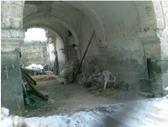
Şekil 6.17. Germir Rum Kilisesi narteksten görünüş
