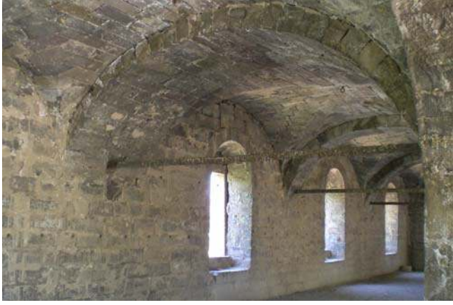
Şekil 5.118. Galeri D4 duvarı
