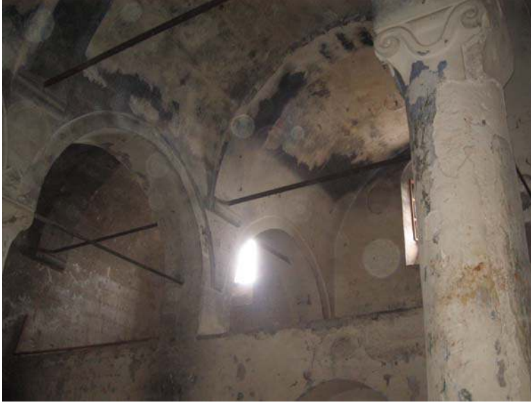
Şekil 6.80. Kaymaklı Kilise galeri katı görünüş
