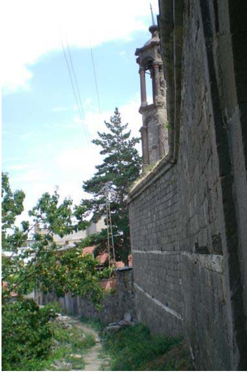
Şekil 5.13. Avlunun dış duvarından görünüm
