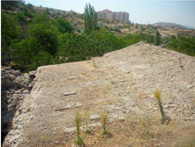
Şekil 5.143. Çatı genel görünümü
