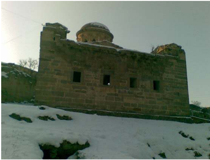
Şekil 6.11. Germir Rum Kilisesi doğudan görünüş
