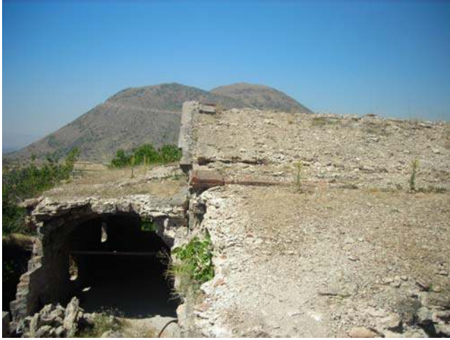
Şekil 5.140. Çatıdan yıkılmış galeri görünümü
