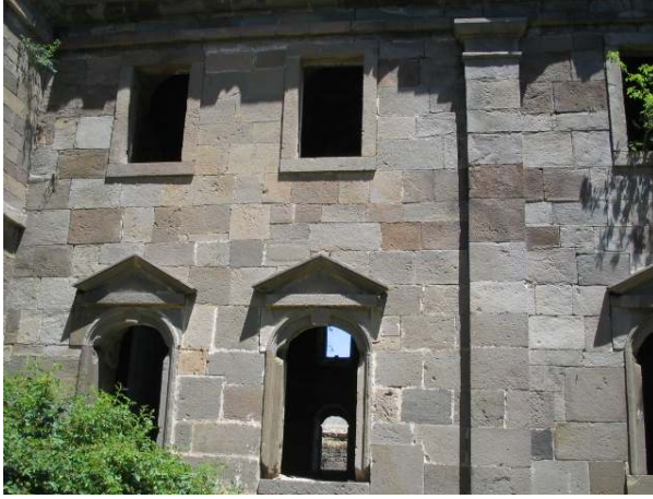
Şekil 5.55. Güney cephesi pencereler
