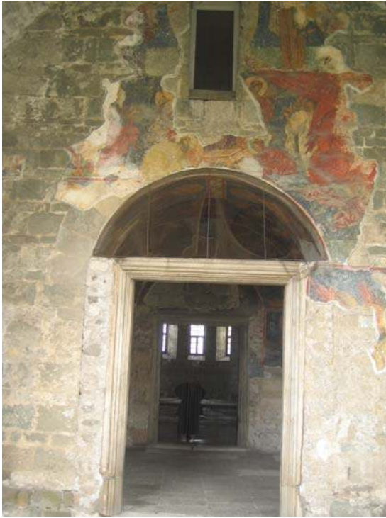
Şekil 6.114. Trabzon Ayasofya Kilisesi yan giriş kapısı
