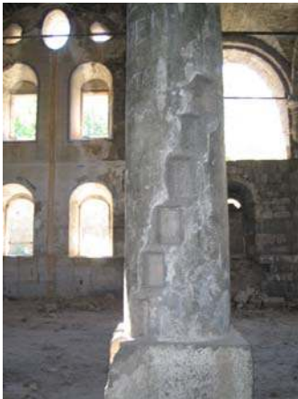
Şekil 7.36. Endürlük Kilisesi ambona çıkış merdiven izleri
