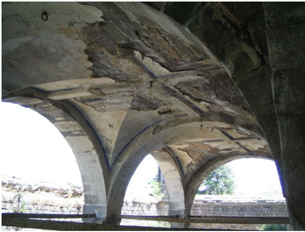
Şekil 5.31. Çapraz tonoz
