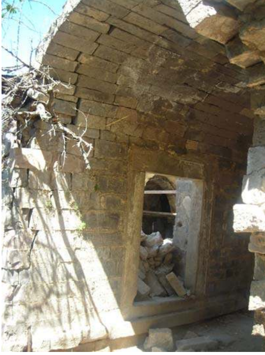
Şekil 5.131. 101 mekanı D2 duvarı K4 kapısı
