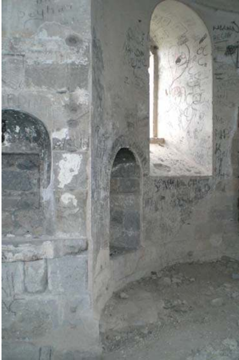
Şekil 5.82. Apsis niş ve pencere detayı
