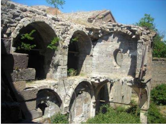
Şekil 7.1. Yıkılan güney cephesi fotoğraf
