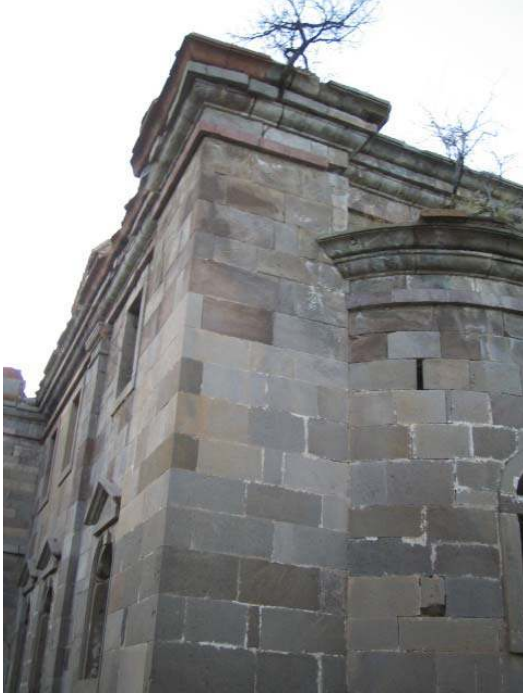
Şekil 5.65. Apsislerin duvar ile birleşimi
