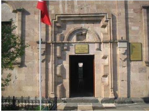
Şekil 6.133. Gogara Kilisesi güney giriş kapısı görünüş
