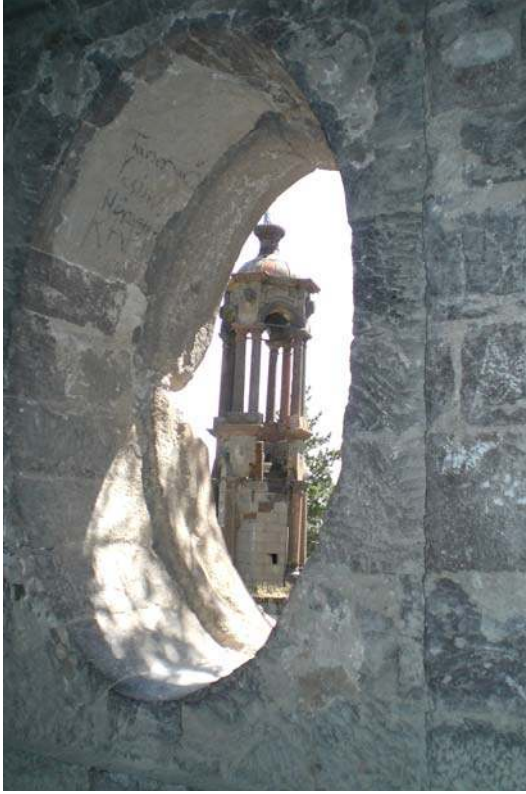
Şekil 5.121. P.5.1 penceresi iç görünüm
