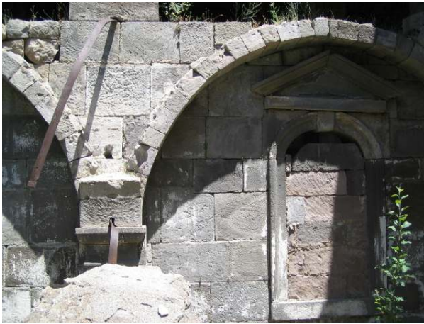
Şekil 5.56. Güney cephesi galeri altı kapatılmış pencere
