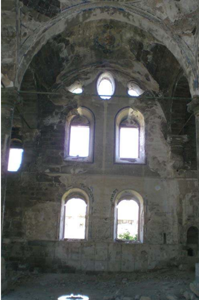
Şekil 5.99. D2 duvarı pencereler
