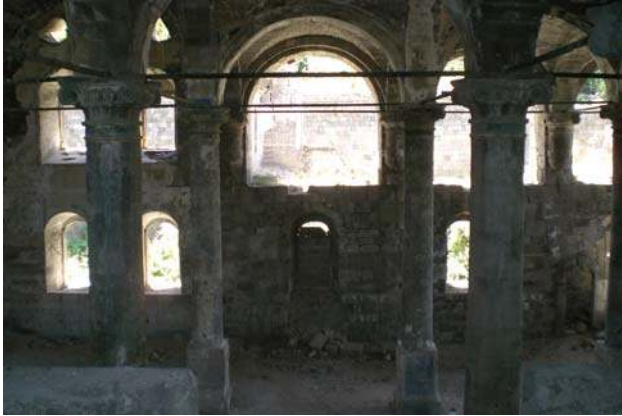
Şekil 5.92. D7 duvarı iç görünüş
