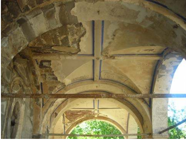
Şekil 5.29. Çapraz tonoz görünümü
