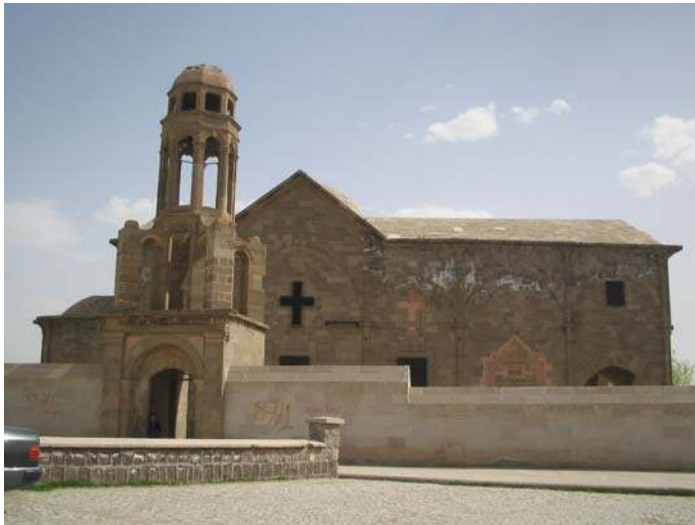
Şekil 6.89. Aziz Theodoros Kilisesi kuzey görünüş
