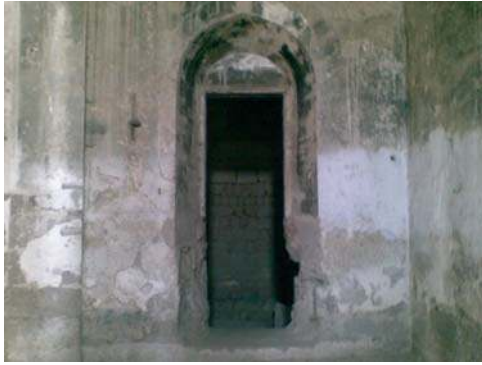
Şekil 6.27. İncesu Rum Kilisesi batı penceresinin bugünkü durumu
