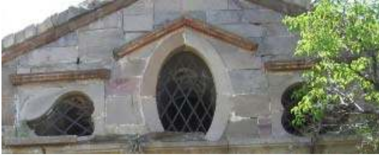
Şekil 7.30. Endürlük Kilisesi kuzey tepe pencereleri detayı
