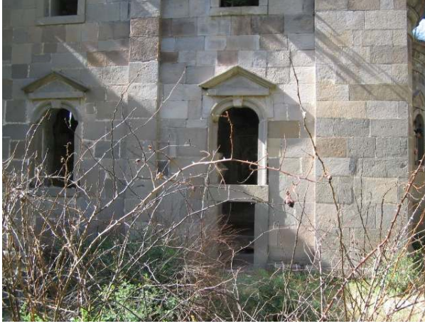
Şekil 5.54. Güney cephesi K3 kapısı
