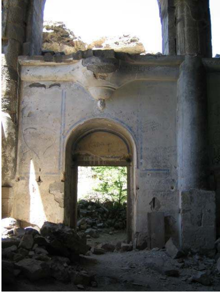
Şekil 5.76. K.1.1 kapısının iç görünümü
