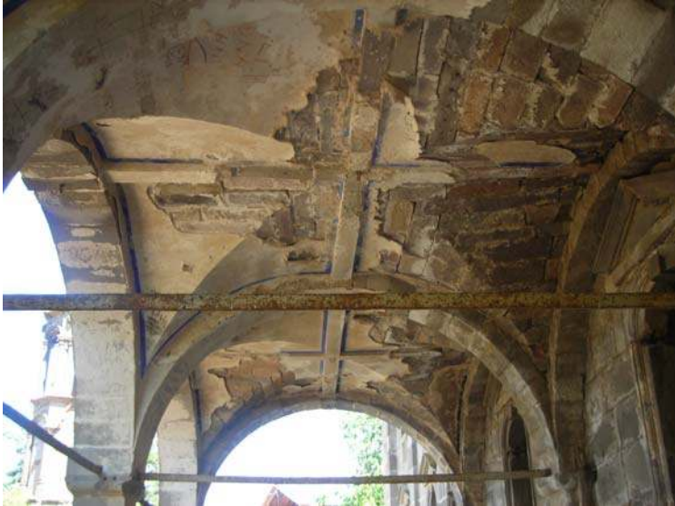
Şekil 5.28. Çapraz tonoz görünümü
