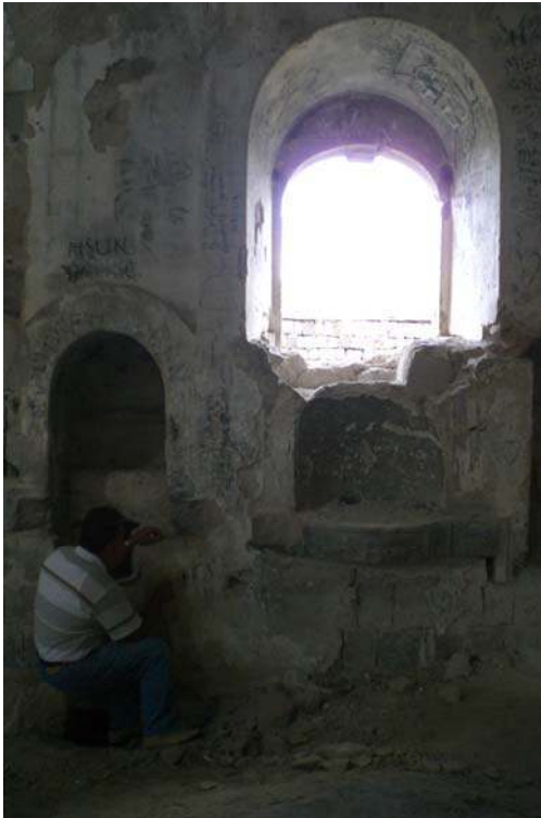
Şekil 5.84. Kuzey cephesinden pencere detayı
