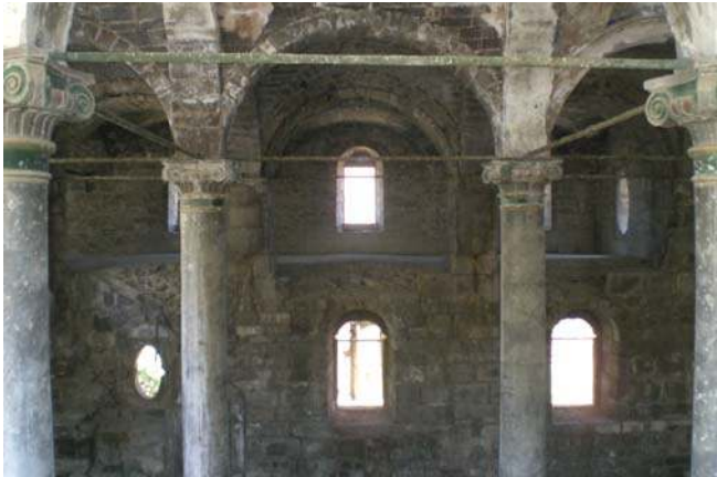
Şekil 5.97. D2 duvarı içten görünümü
