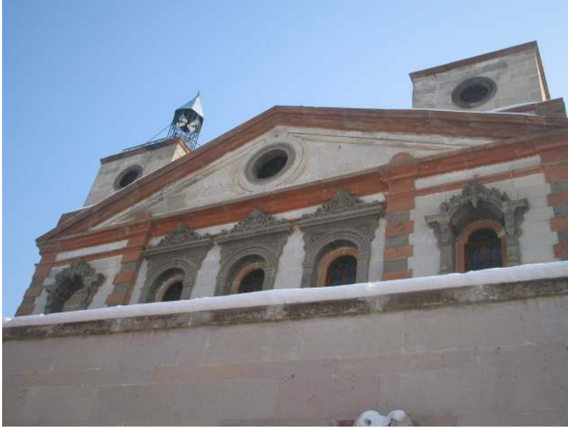
Şekil 6.34. Panaya Kilisesi batı galeri katı pencereleri görünüş
