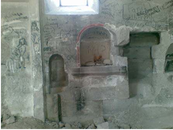
Şekil 7.13. Yanartaş Rum Kilisesi kuzey iç duvar nişleri
