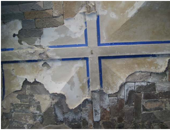
Şekil 5.47. Galeri altı çapraz tonoz
