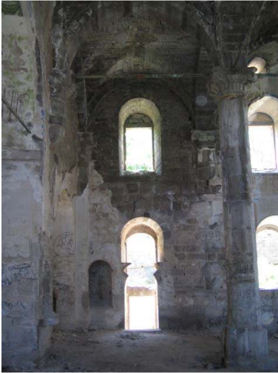
Şekil 5.94. D7 duvarı kapı
