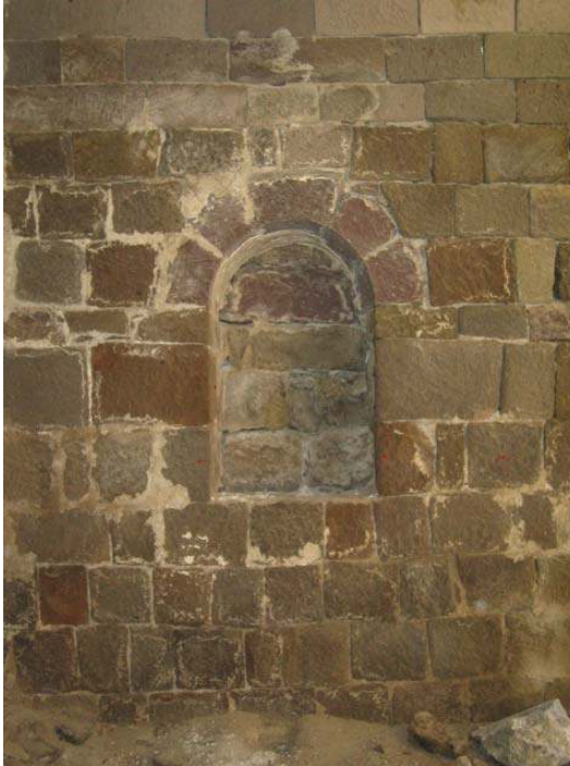
Şekil 5.134. Z02 mekanındaki niş
