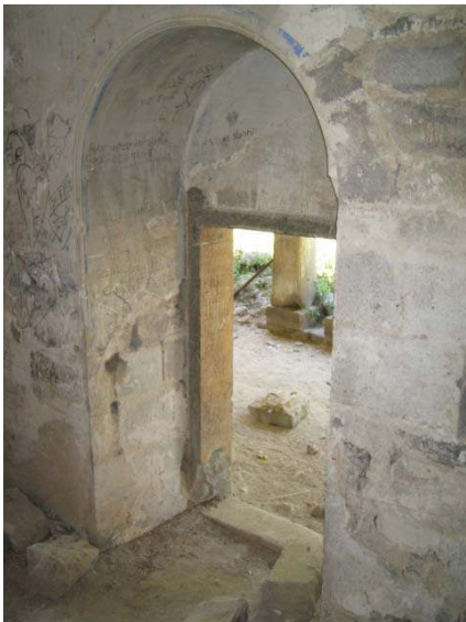
Şekil 5.75. K.1.2 kapısının iç görünümü
