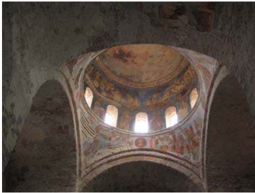
Şekil 6.112. Trabzon Ayasofya Kilisesi kasnaklı kubbe içten görünüşü
