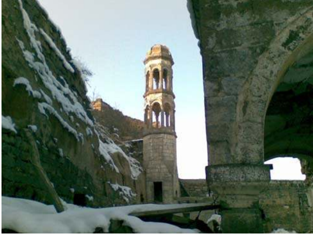
Şekil 6.12. Germir Rum Kilisesi çan kulesi
