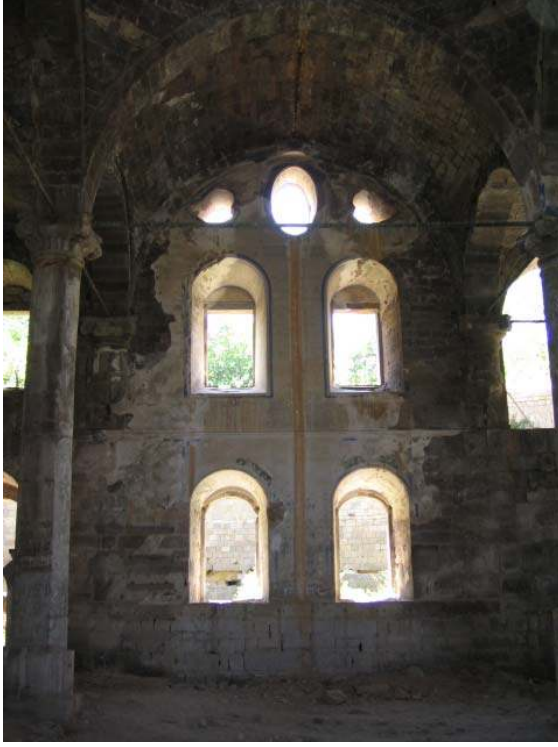
Şekil 5.93. D7 duvarı pencereler
