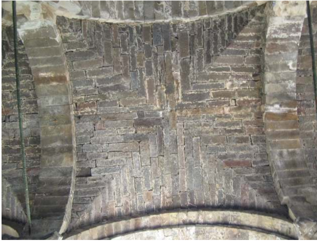
Şekil 5.114. Çapraz tonoz görünüm
