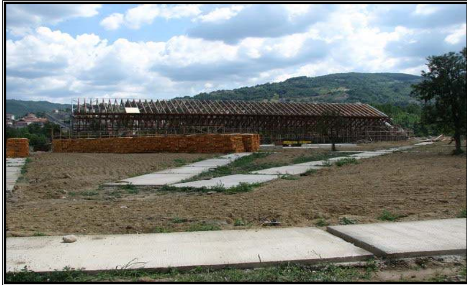
Fotoğraf 24: Kuzey Cepheden Görünüm 143 .
