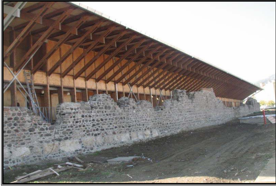
Fotoğraf 33: Kuzey Cepheden Görünüm 152 .
