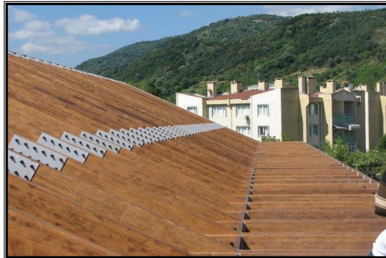
Fotoğraf 22: Çatı Konstrüksiyonundan Görünüm 141 .
