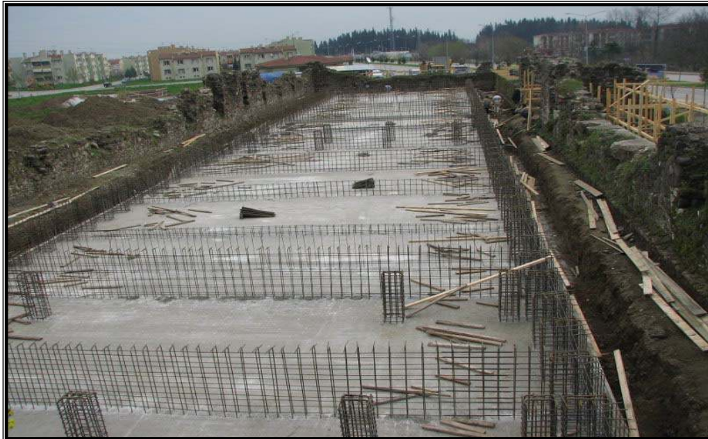
Fotoğraf 14: Radye Temel Plağı Betonundan Görünüm 134 .
