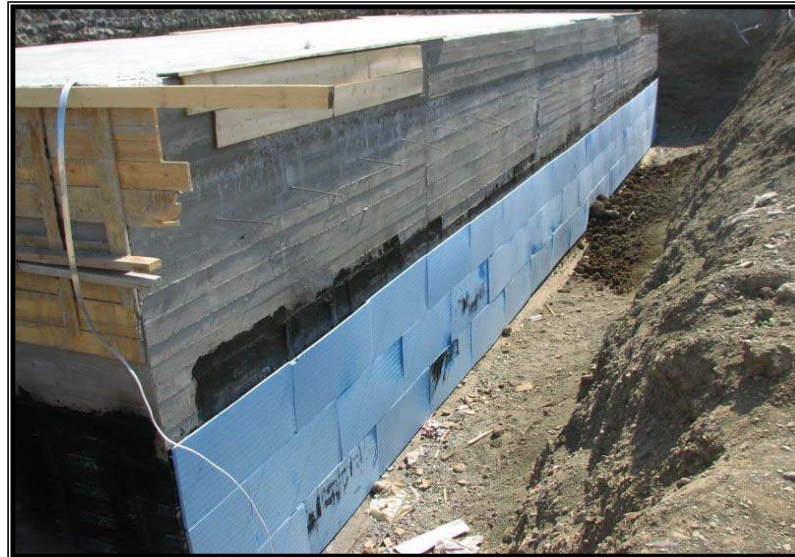
Fotoğraf 18: Su Deposunun Temel Bölümünden Görünüm 137 .
