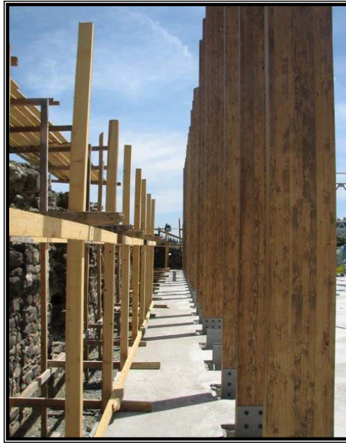
Fotoğraf 19: Ahşap Dikmelerden Görünüm 138 .
