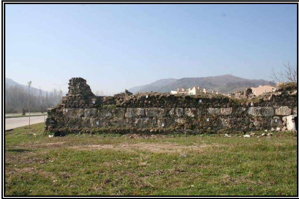
Fotoğraf 11: Subasman Seviyesindeki Kesme Taşlardan Görünüm 130 .
