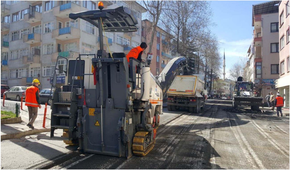
Şekil 8. RAP malzemesinin kazınarak kamyonu yüklenmesi
