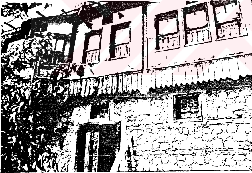
F 53 Geç tarihli evlerde ahşap cephe kaplamasının sınırlı kullanımı (Ev no: 27)
