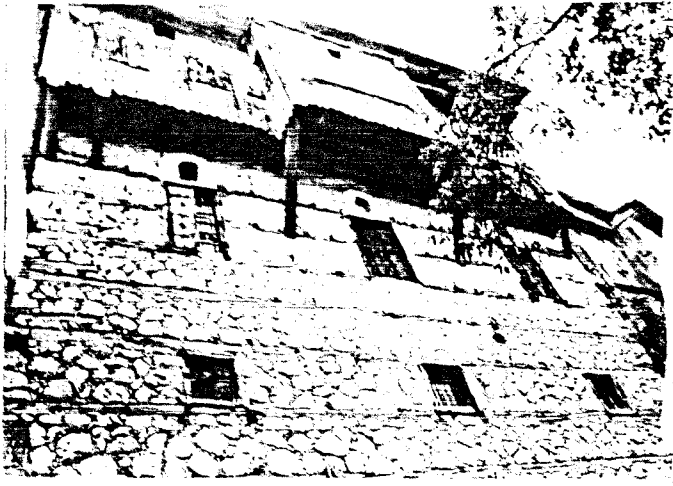
F 67 Taş duvarlarda birim modülde tek pencere biçimlemesi (Ev no: 73)
