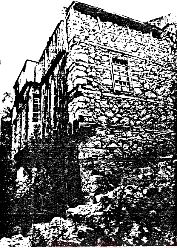
F 47 Taş duvarın saçak düzeyine kadar yükseltilmesi (Ev no: 38)
