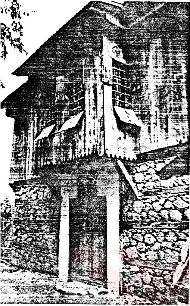
4 Kaçak Kat'da sofanın çıkma yapması (Ev no: 36)
