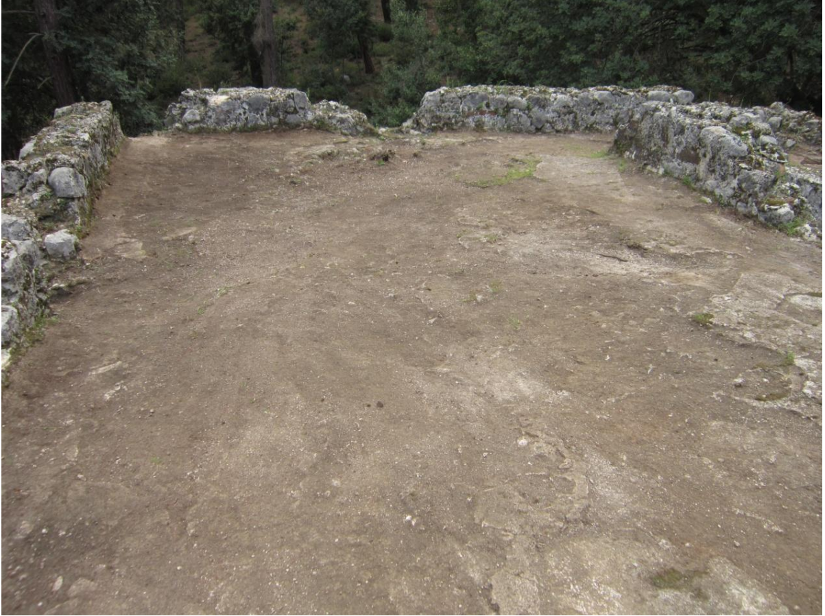
Foto 106 Çatı Parapet Duvarları ve Horosan Harçlı Zemin
