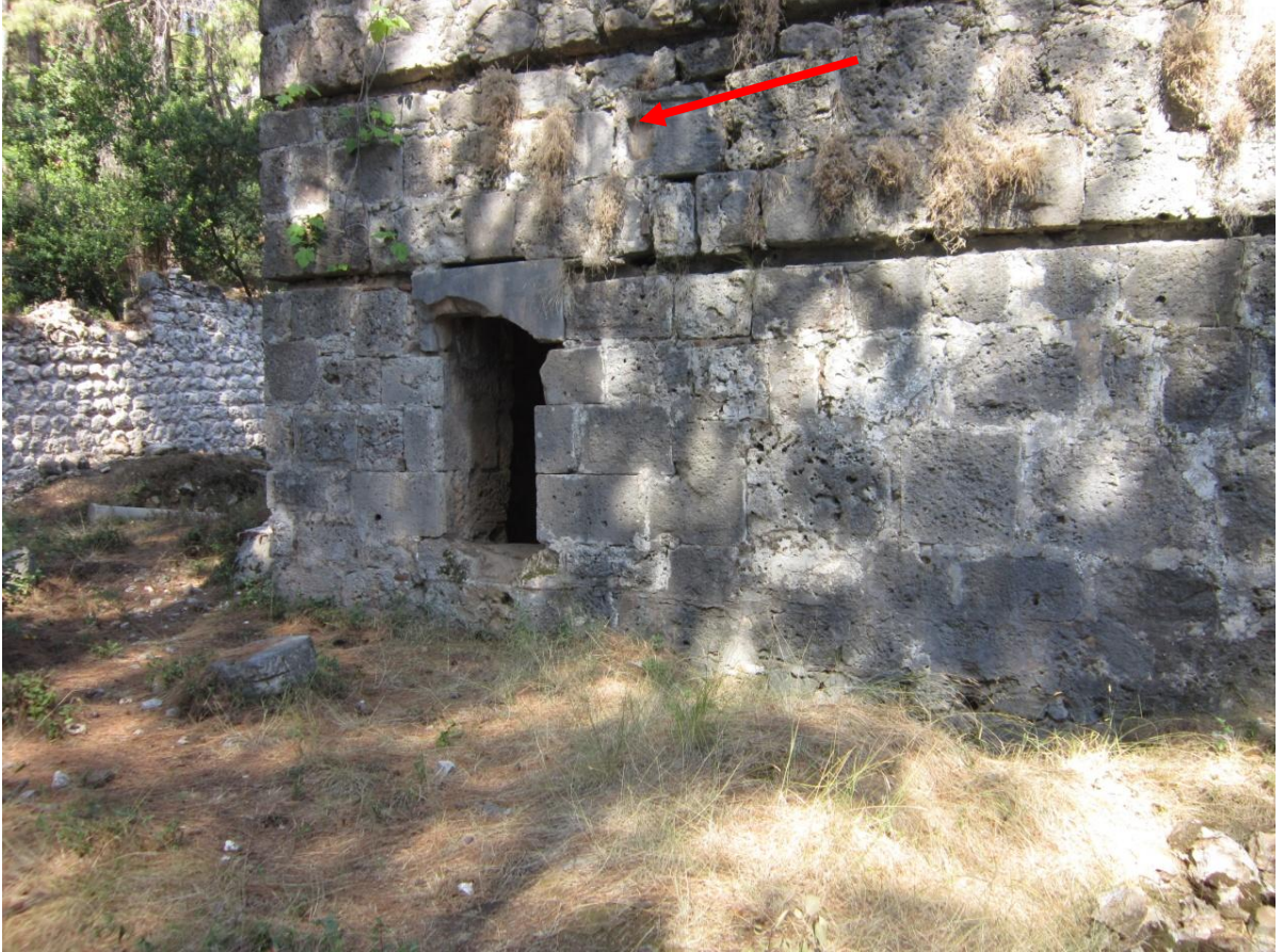
Foto 100 Köşk Güneybatı Cephede Devşirme Malzeme
