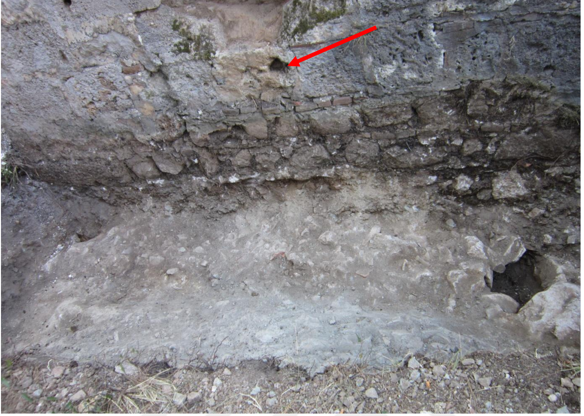
Foto 109 Köşk Binası İçinden II. Avluya Dökülen Künk Yuvası
