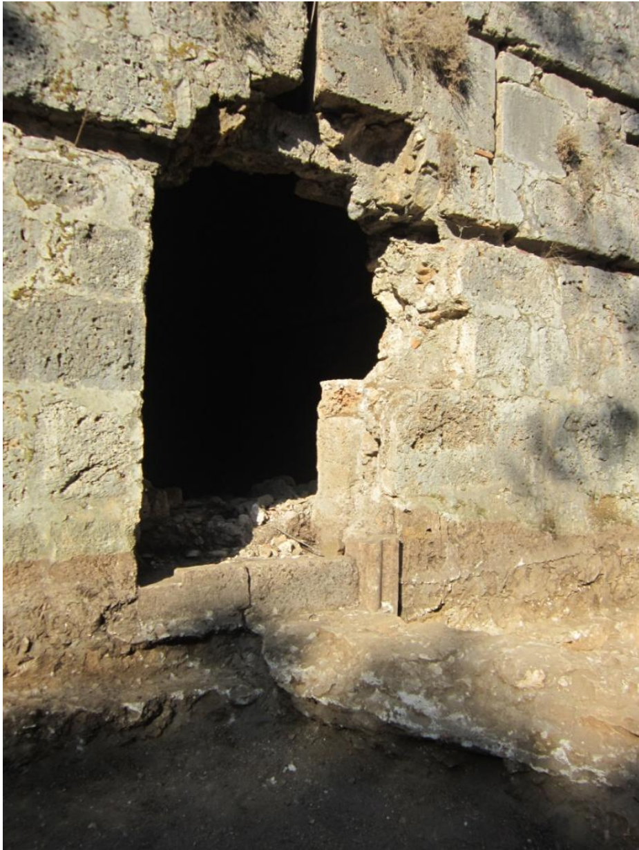
Foto 26 Kuzeydoğu Cephe Köşk Giriş Kapısı
