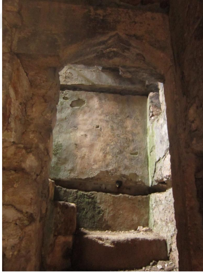
Foto 40 Merdiven Sahanlığına Açılan Kapı
