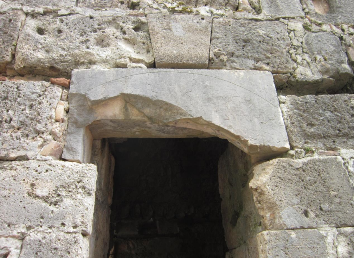
Foto 102 Köşk Güneybatı Cephesinde Yer Alan Dikdörtgen Formlu Pencere
