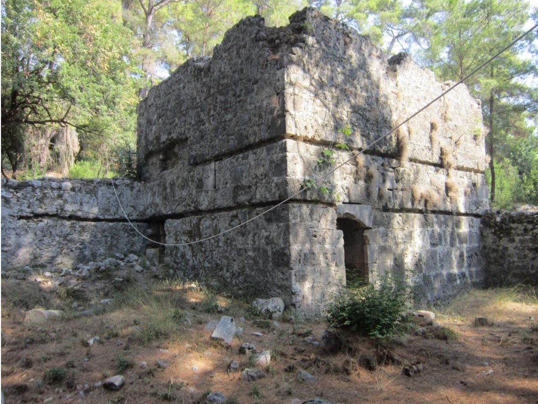
Foto 20 Köşk Ana Binası Dıştan Görünüm
