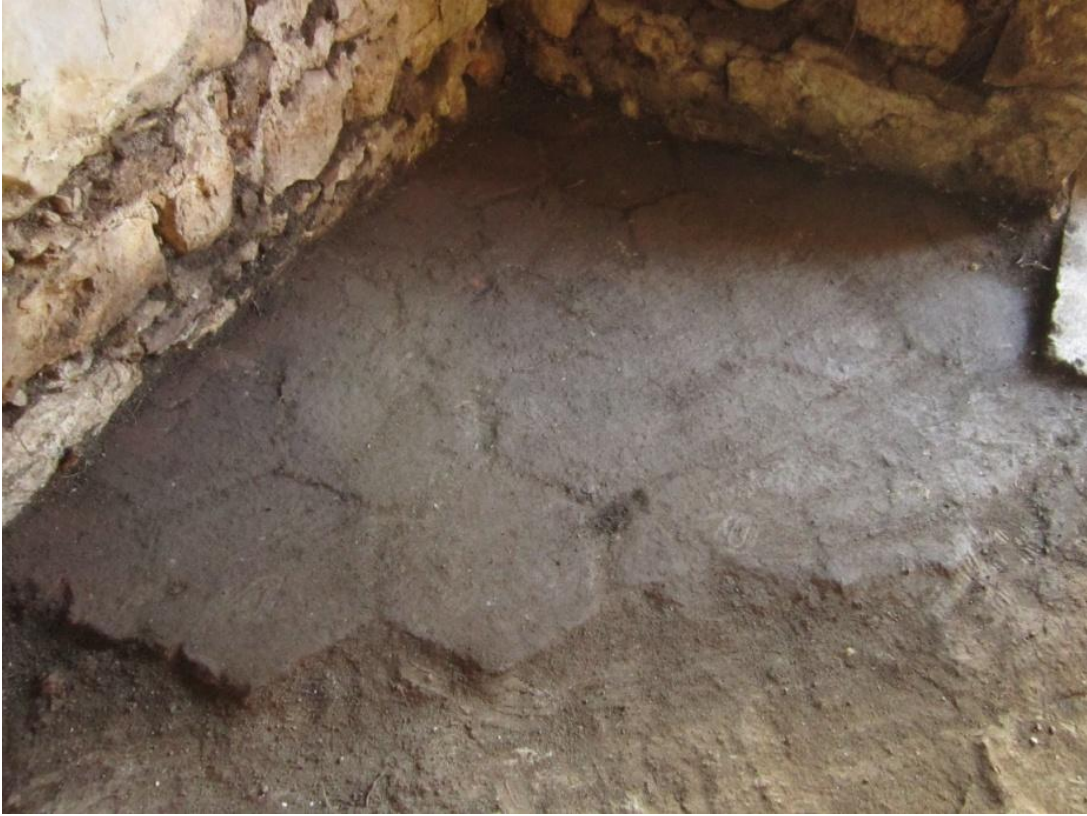
Foto 36 Sofa Zemin Döşemesinden Kalan Kısımlar
