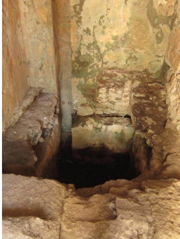
Foto 30 Sıcaklık Mekanı Kapı Eşiği
