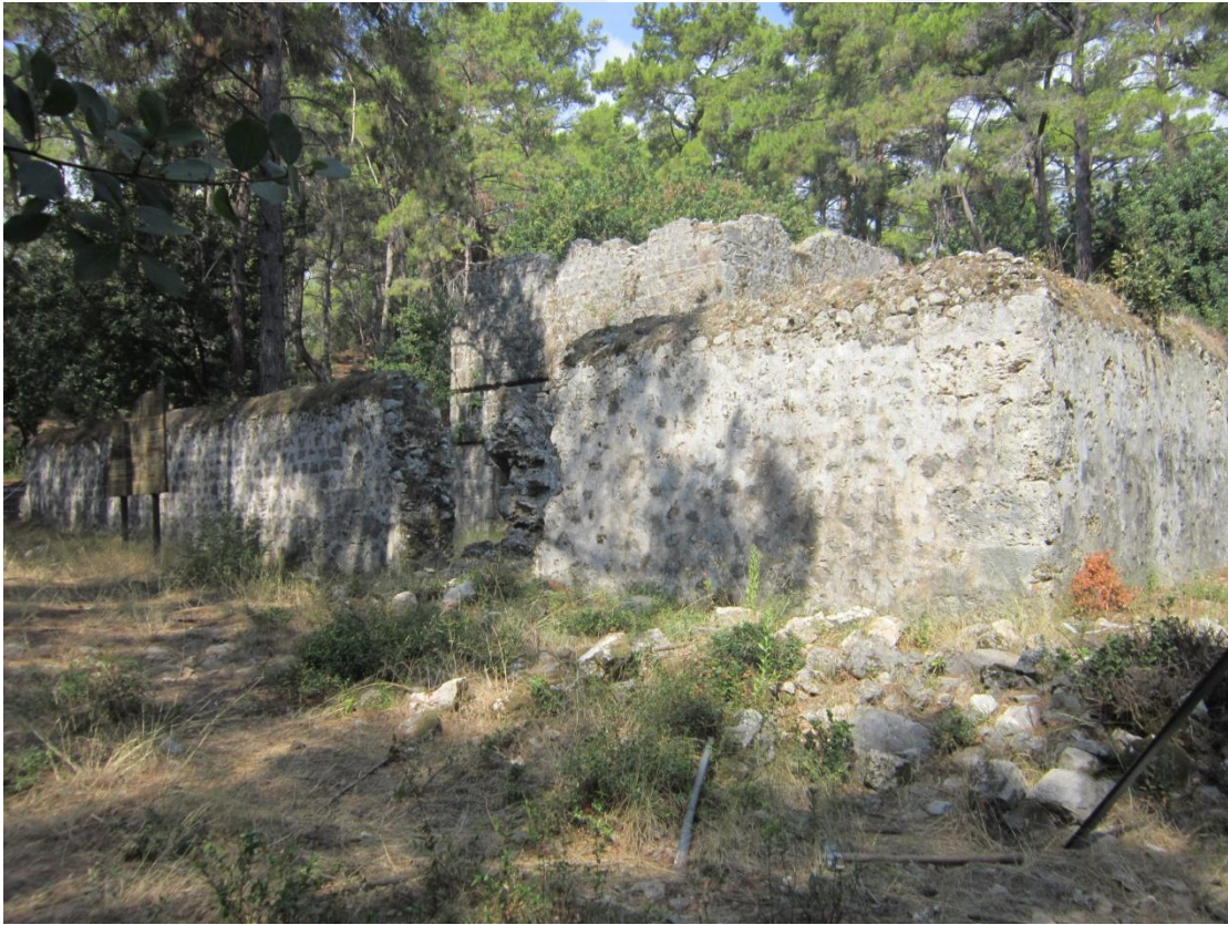
Foto 2 Köşk Çevre Duvarları
