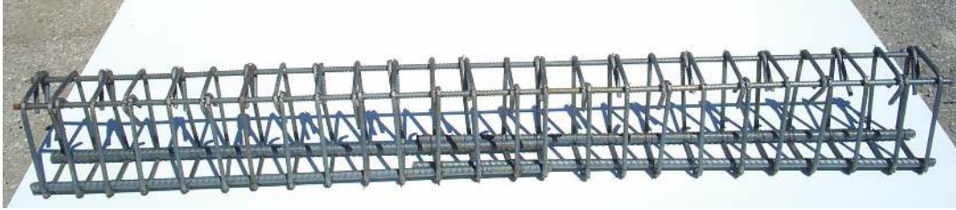
Şekil 5.3 Kirişlerde kullanılan donatının teşkili
