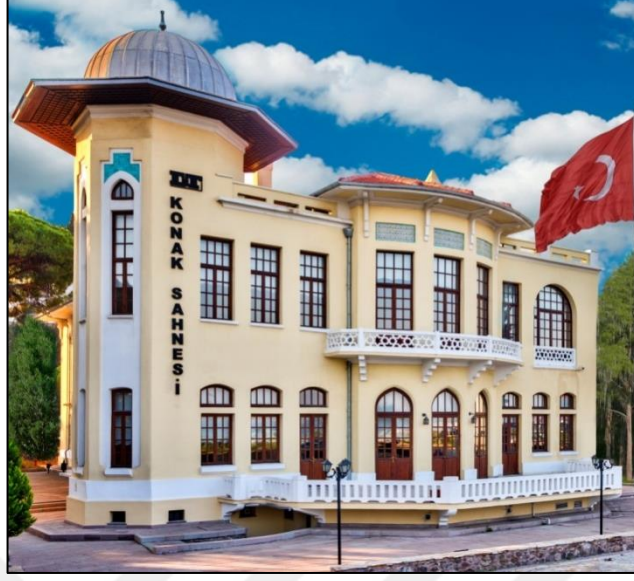
Resim 20, Konak Sahnesi, Restorasyon Sonrası Dış Görünüm, Kaynak: İzmir Devlet Tiyatrosu
